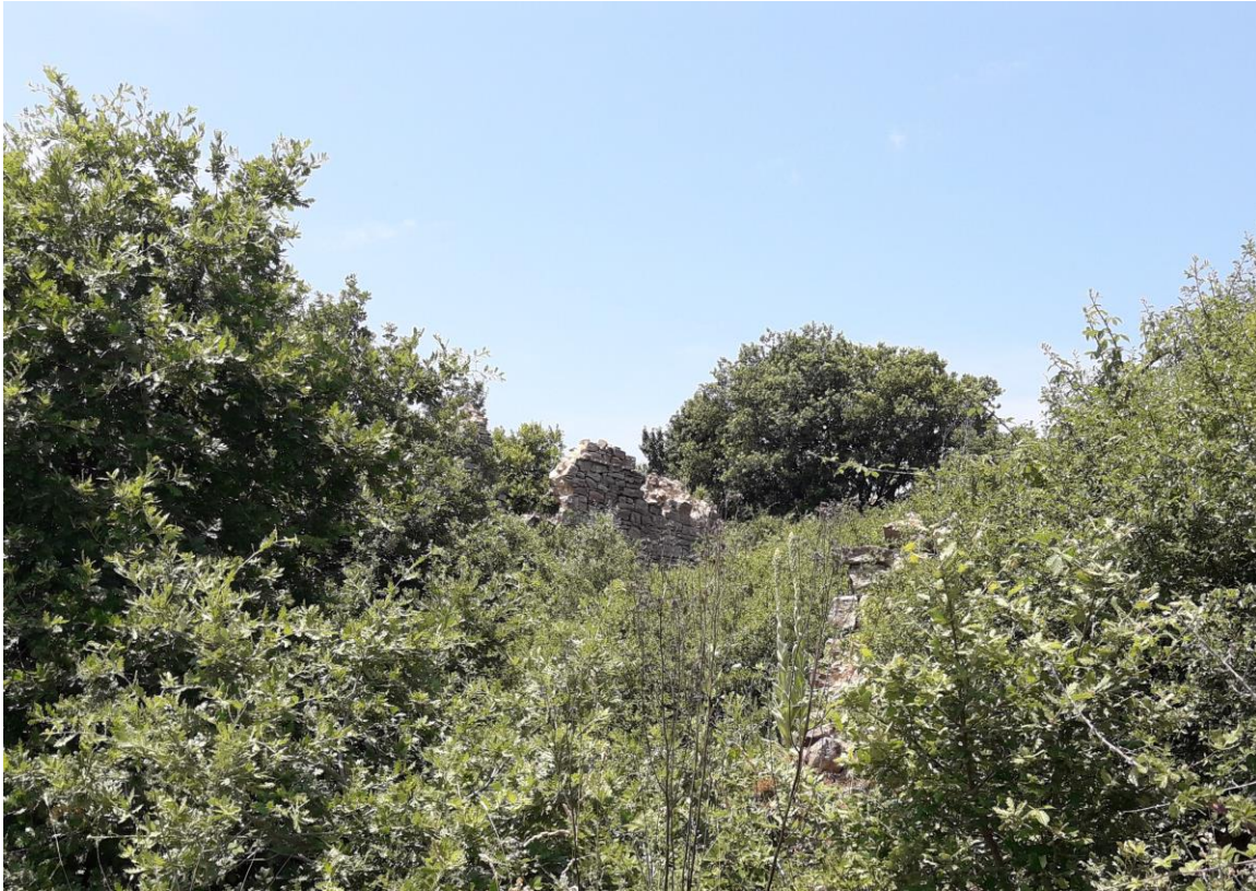
Figura – Rudere di Casino Clemente , presente nei pressi del sito progettuale (Foto Studio Rocco Carella).
