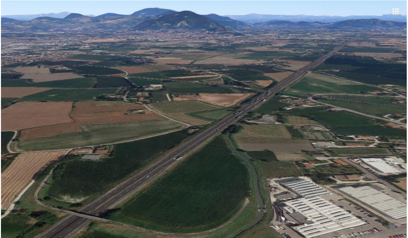
Vista panoramica dell'area d'intervento
