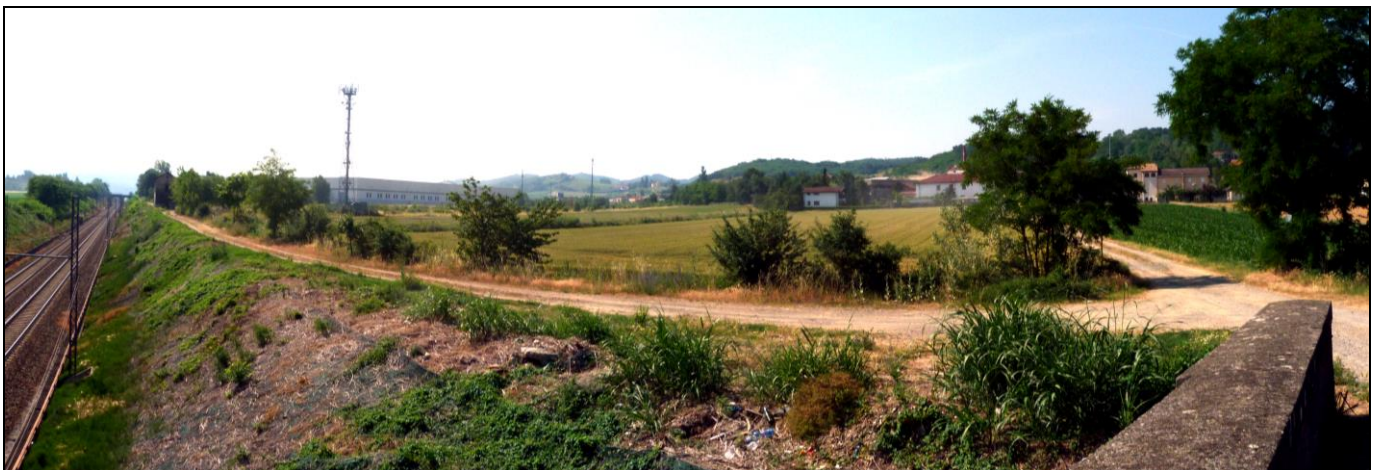
Figura 2-3 Panoramica sull'area di cantiere vista dal cavalcaferrovia esistente
