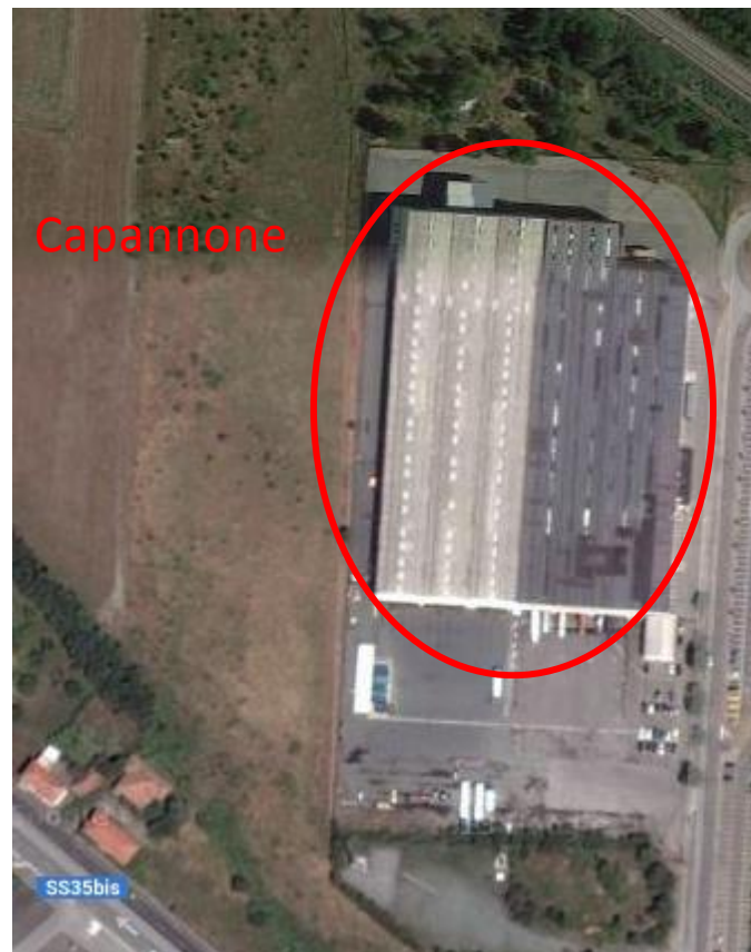
Figura 11-1 - Immagine fotografica del capannone interferente con lo scavo
