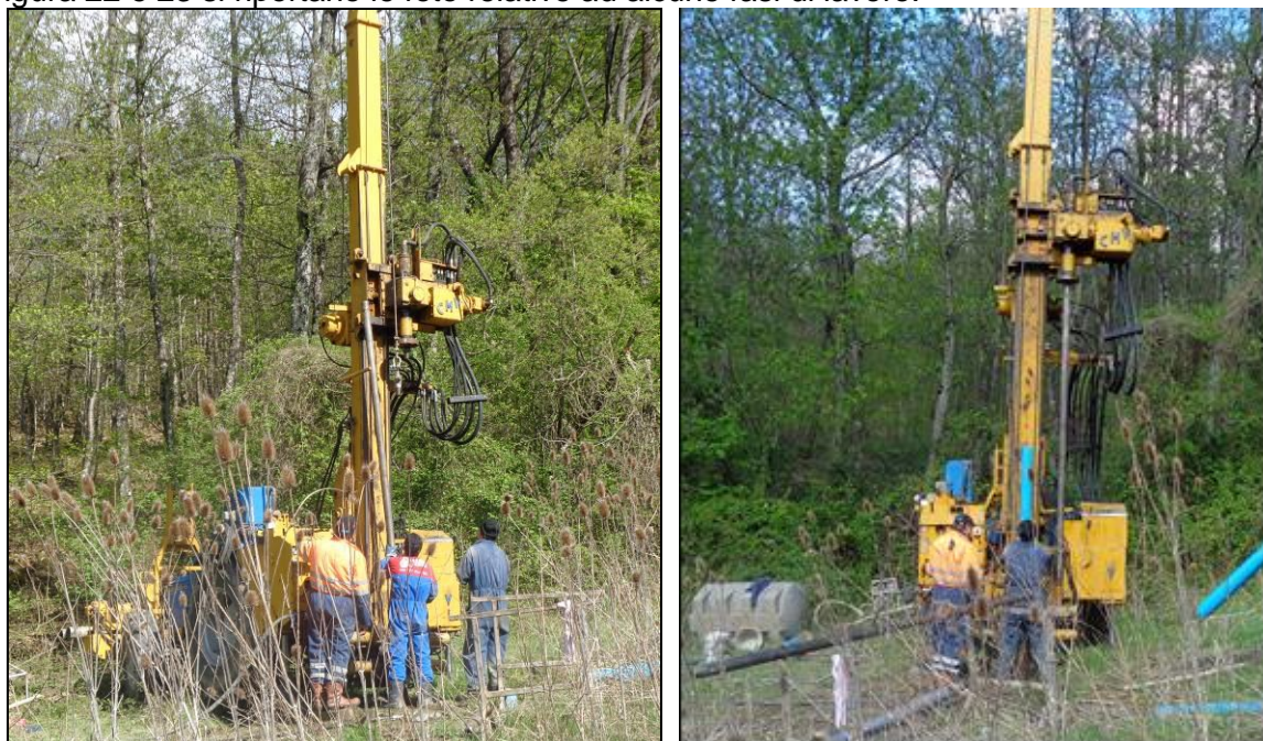
Figura 22-23 – Fase di perforazione e fase di inserimento tubazione microfessurata piezometro M3m
