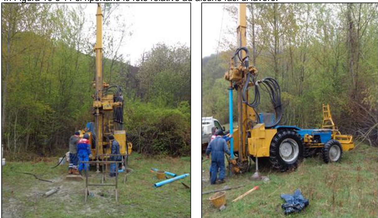
Figura 10-11 – Fase di perforazione e fase di inserimento tubazione microfessurata piezometro M1m
