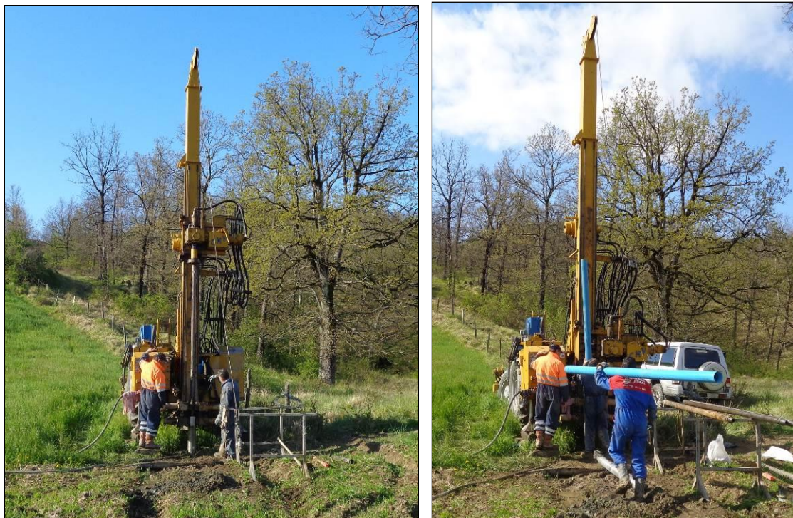
Figura 34-35 – Fase di perforazione e fase di inserimento tubazione microfessurata piezometro M5m
