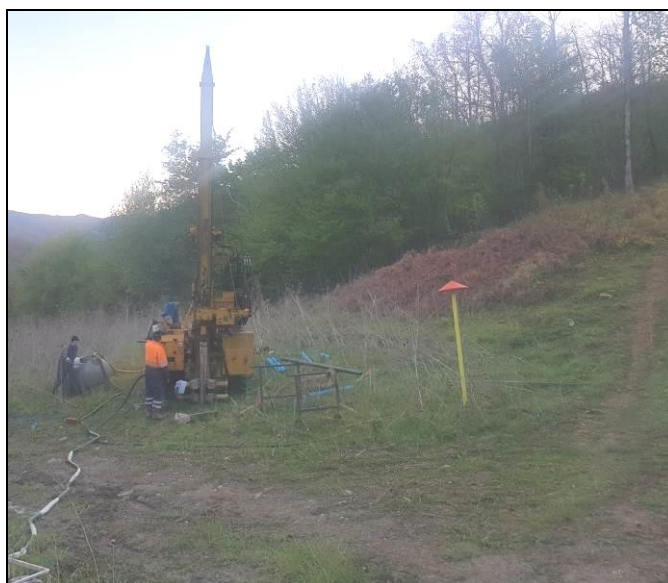
Figura 37 – Fase di perforazione nuovo piezometro M3
