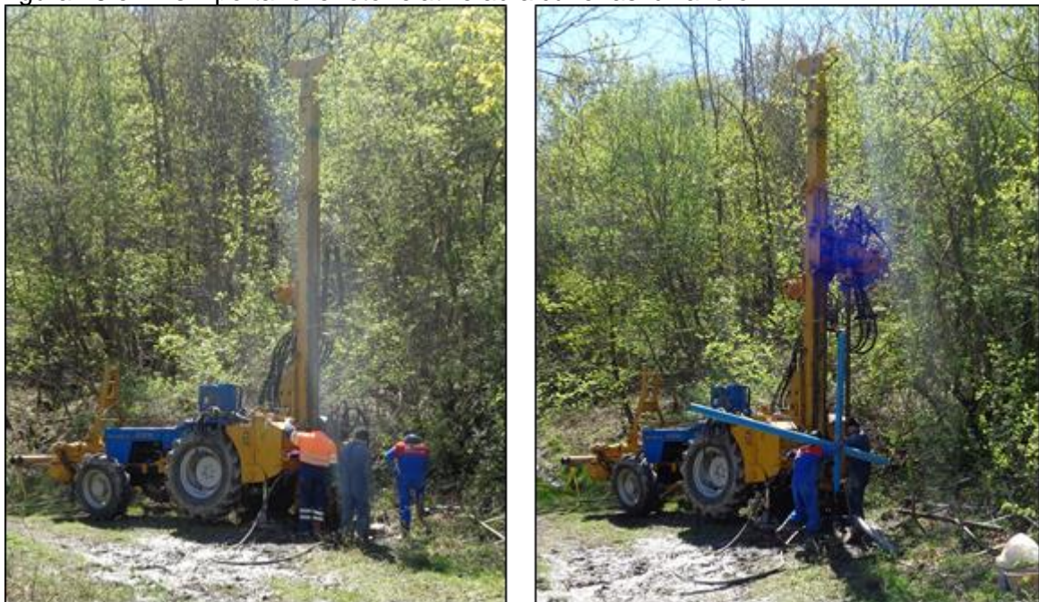
Figura 16-17 – Fase di perforazione e fase di inserimento tubazione microfessurata piezometro M2m
