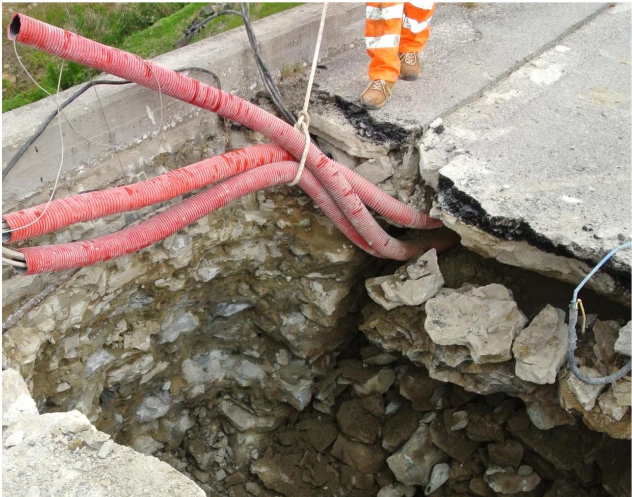
Figura 4-17 - Trincea prima delle operazioni di ripristino: è evidente l'interfaccia tra riempimento in rockfill retrostante e la muratura costituente la struttura portante del paramento di monte
