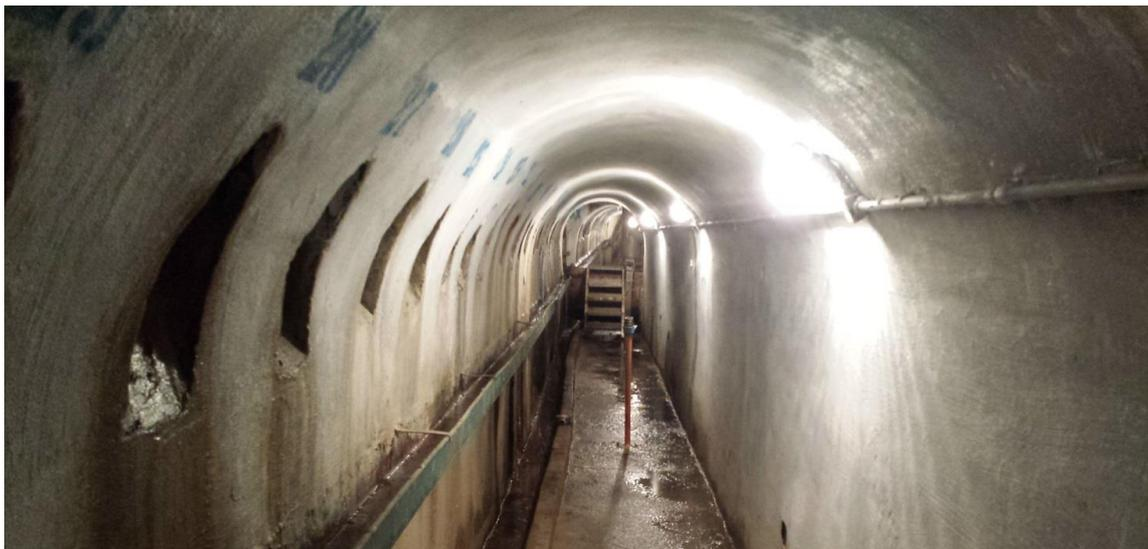
Figura 4-4 – Cunicolo di ispezione e sbocco dei condotti di drenaggio
