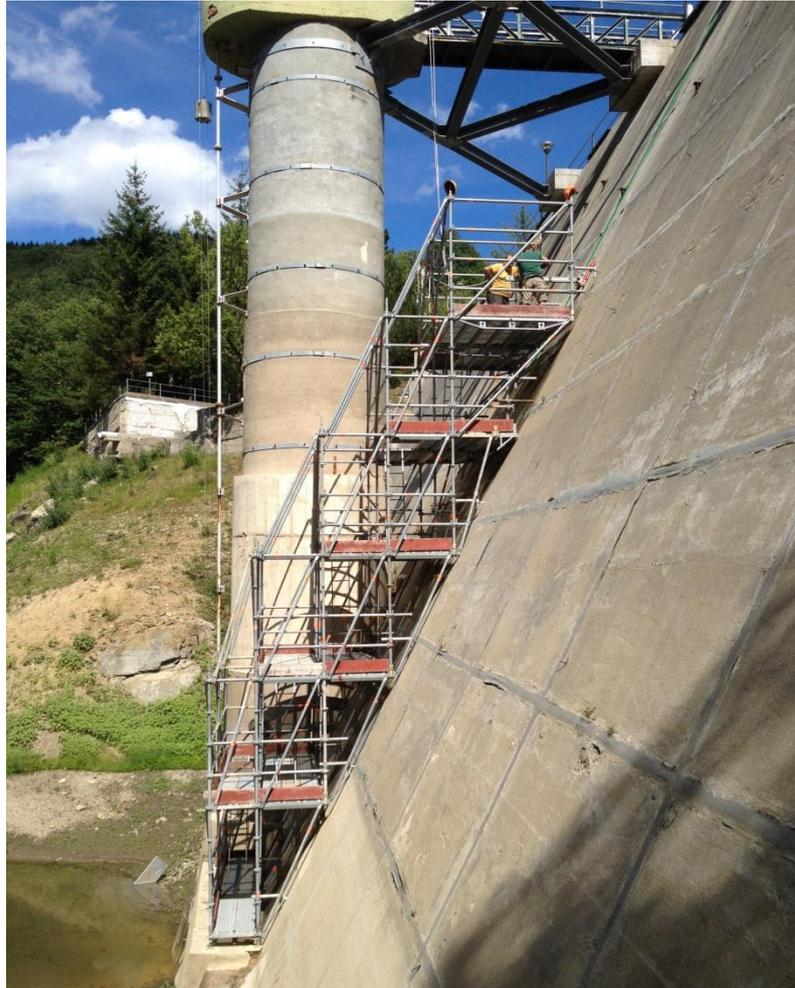
Figura 4-12 – Impalcatura per la realizzazione dei carotaggi sul manto di monte
