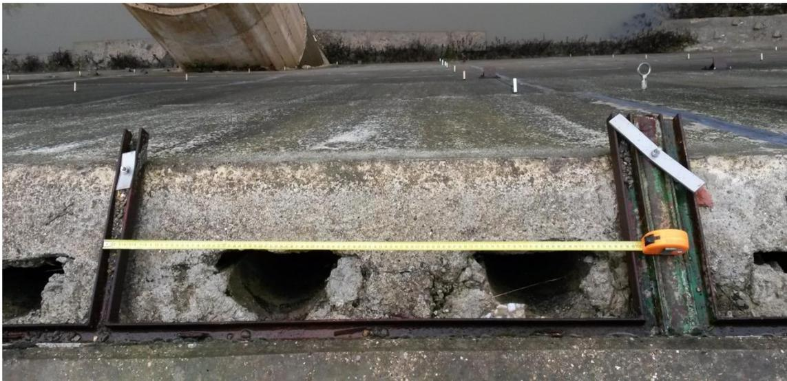
Figura 4-3 – Imbocco dei condotti di drenaggio
