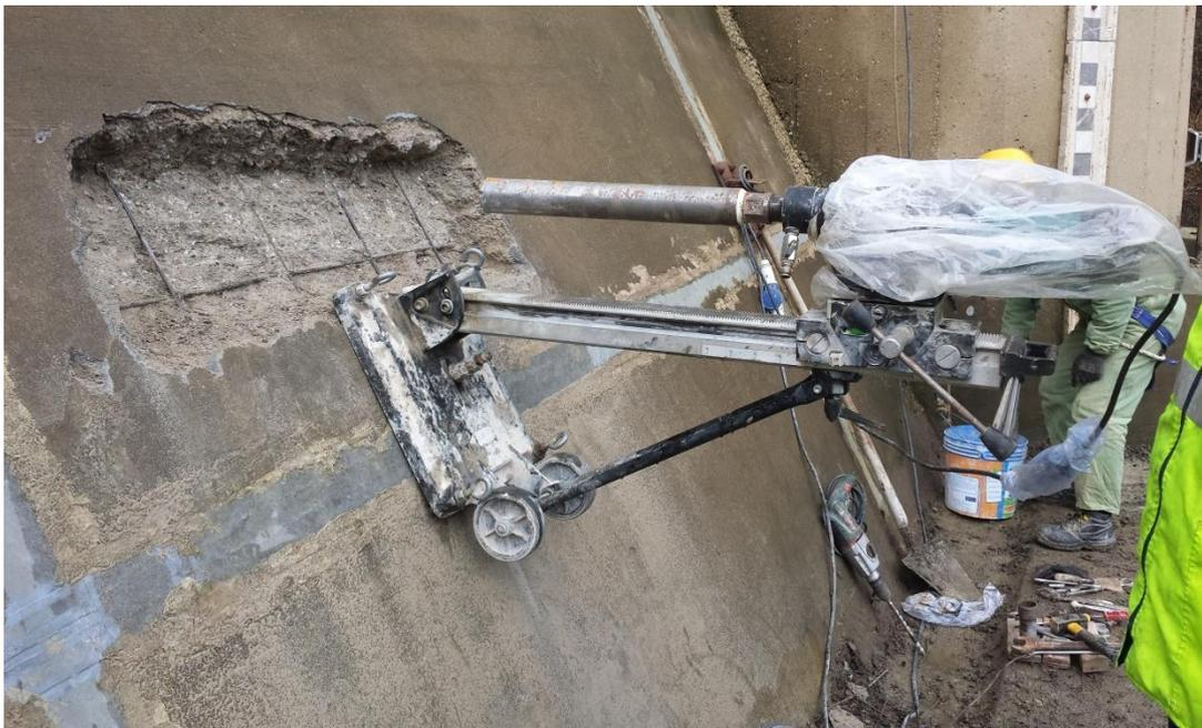
Figura 4-11 – Operazioni di carotaggio sul paramento di monte. Scarifica del rivestimento esterno e messa in luce delle armature delle "dalles" prefabbricate
