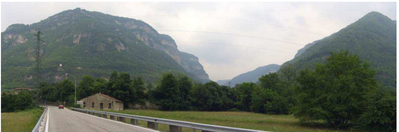
Figura 25: Panoramica in prossimità del viadotto Assa
