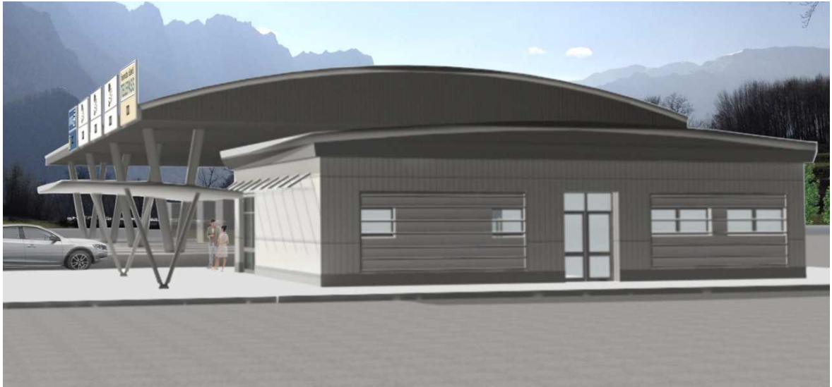
Figura 77 Casello di Pedemonte
