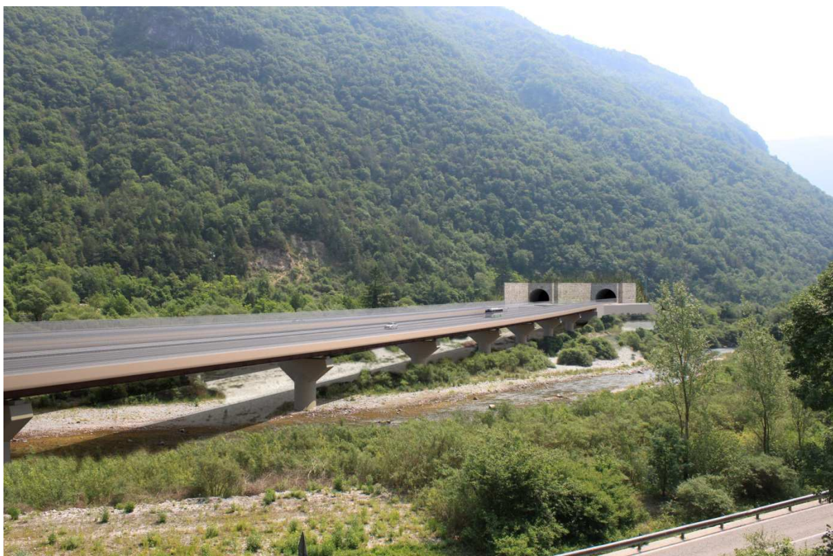
Figura 50 Viadotta Settecà: fotosimulazione dopo 5 anni dall'ultimazione dei lavori
