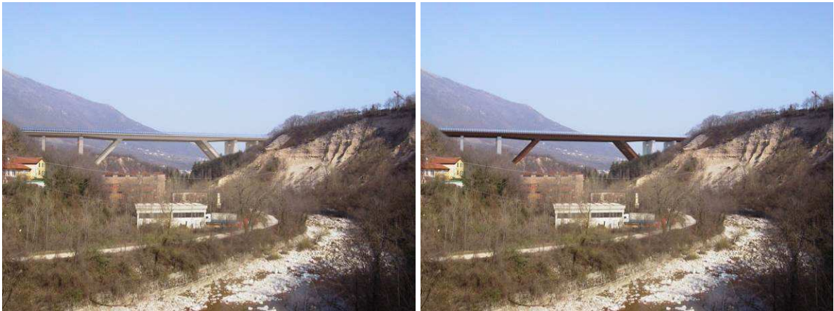
Figura 41: Studio di colori e materiali per il Viadotto Piovene: a sinistra, impalcato e cavalletto in acciaio Cor-ten trattato superficialmente con vernice color greto dell’Astico – la soluzione risulta non percorribile, in quanto si andrebbe a contraddire la specificità dell’acciaio Cor-ten, con notevoli aumenti dell’importo dell’opera, a carico dei trattamenti superficiali; a destra, opera d’arte maggiore bicromatica, scelta considerata poco consona con il paesaggio in cui si inserisce
