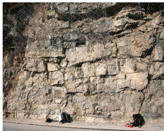
Figura 4 - Geologia – Sequenza stratigrafica – Affioramento della Dolomia Principale presso Valdastico e Pedemonte
