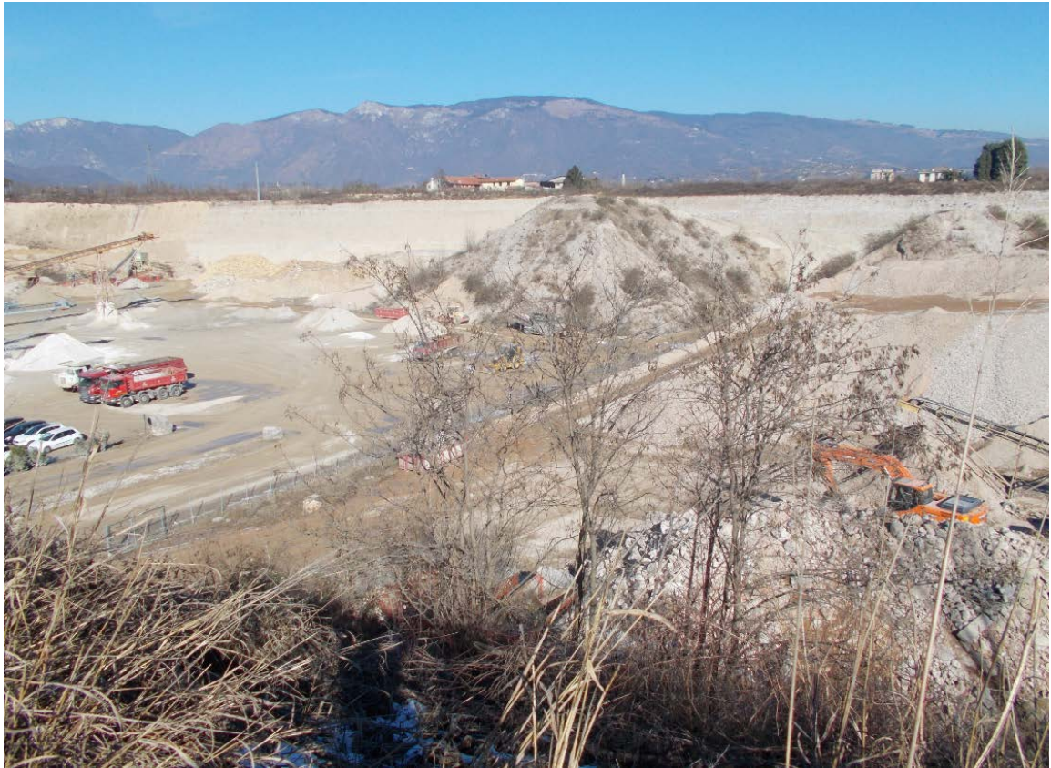
Figura 32 – Vista attuale Cava Zanotto - Vianelle
