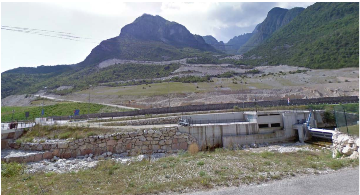
Figura 33 – Vista attuale Cava La Marogna
