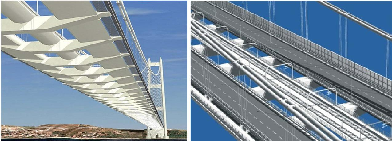
*Figura 3.4 Configurazione dell'impalcato sospeso*
