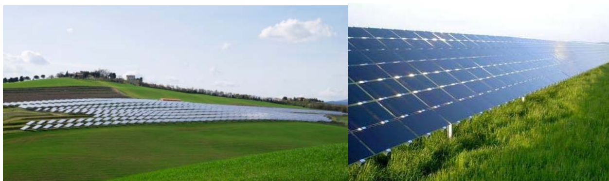
Figura 5.5 Esempi di campo fotovoltaico
