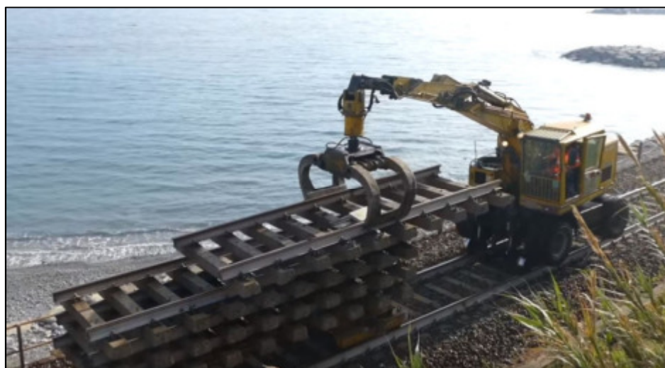
Figura 9 - Posizionamento binario e traverse su carrello trasportatore
