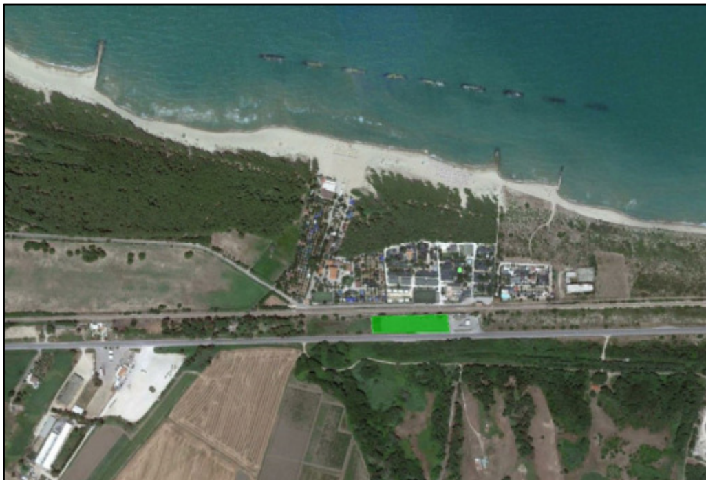
Figura 11 - Foto aerea ASD.01
