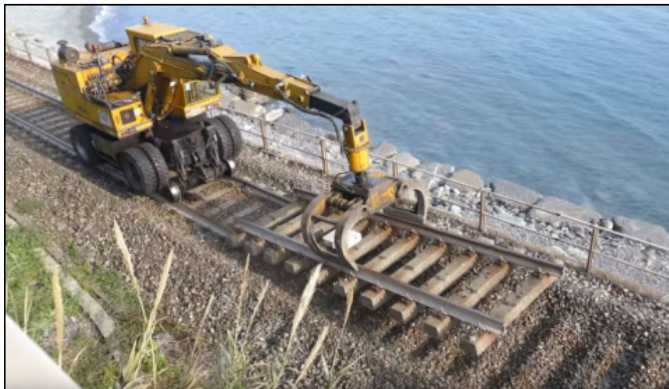
Figura 8 - Sollevamento binario e traverse con mezzo bimodale
