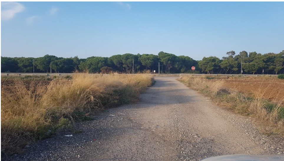
Accesso all'area di cantiere
