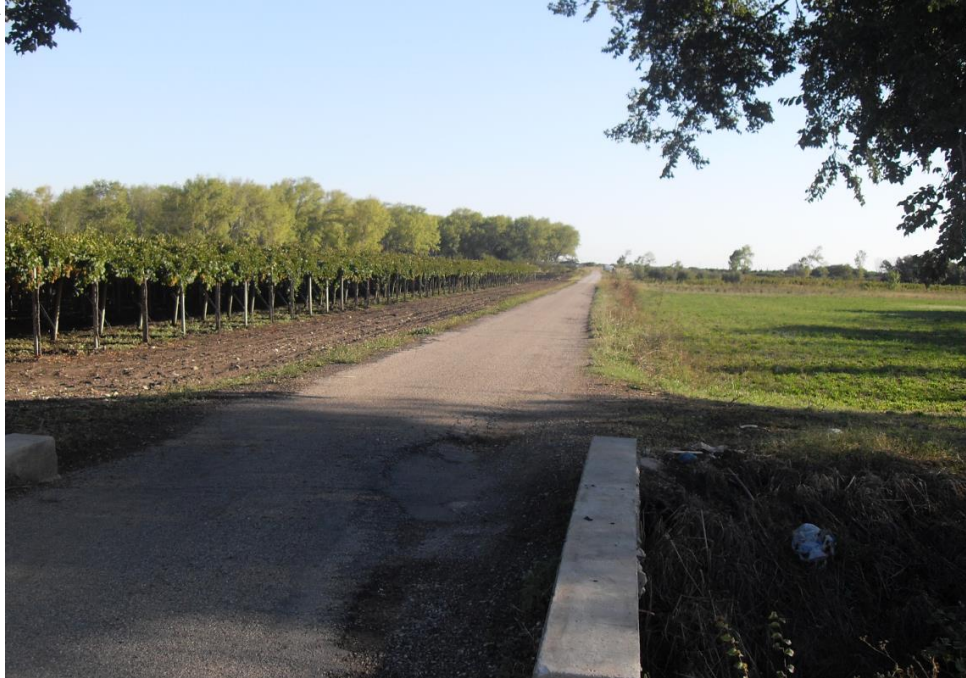
Strada di accesso all'area AT09
