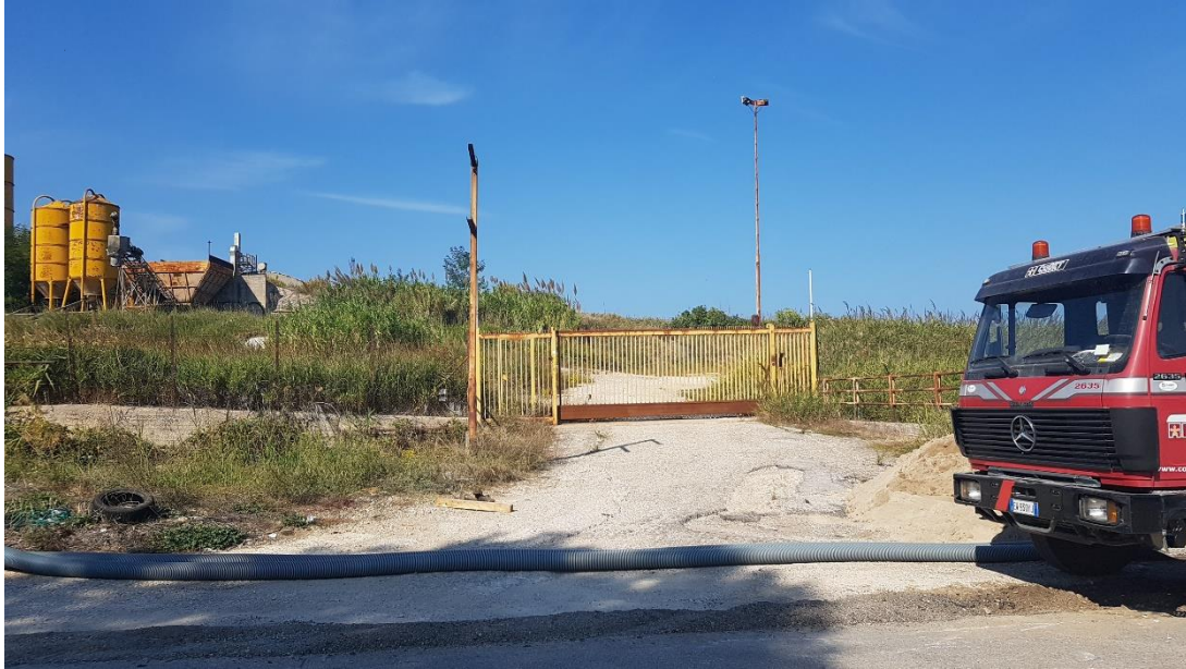
Ingresso all'area di cantiere CO01
