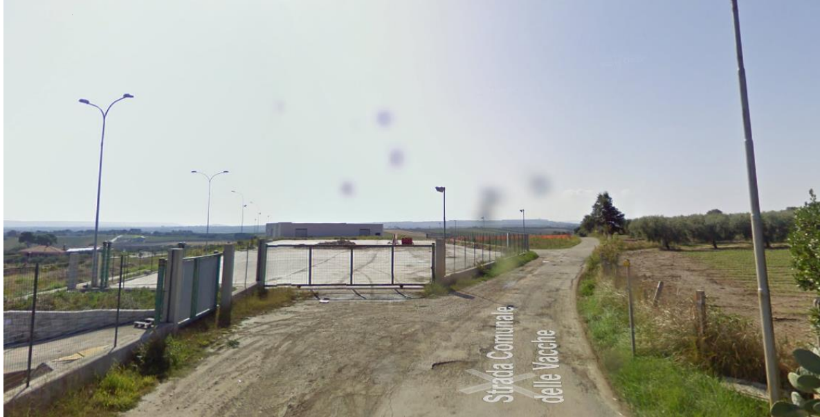
Strada di accesso a CB1
