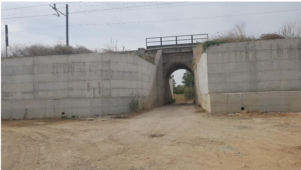
Sotto attraversamento alla linea storica
