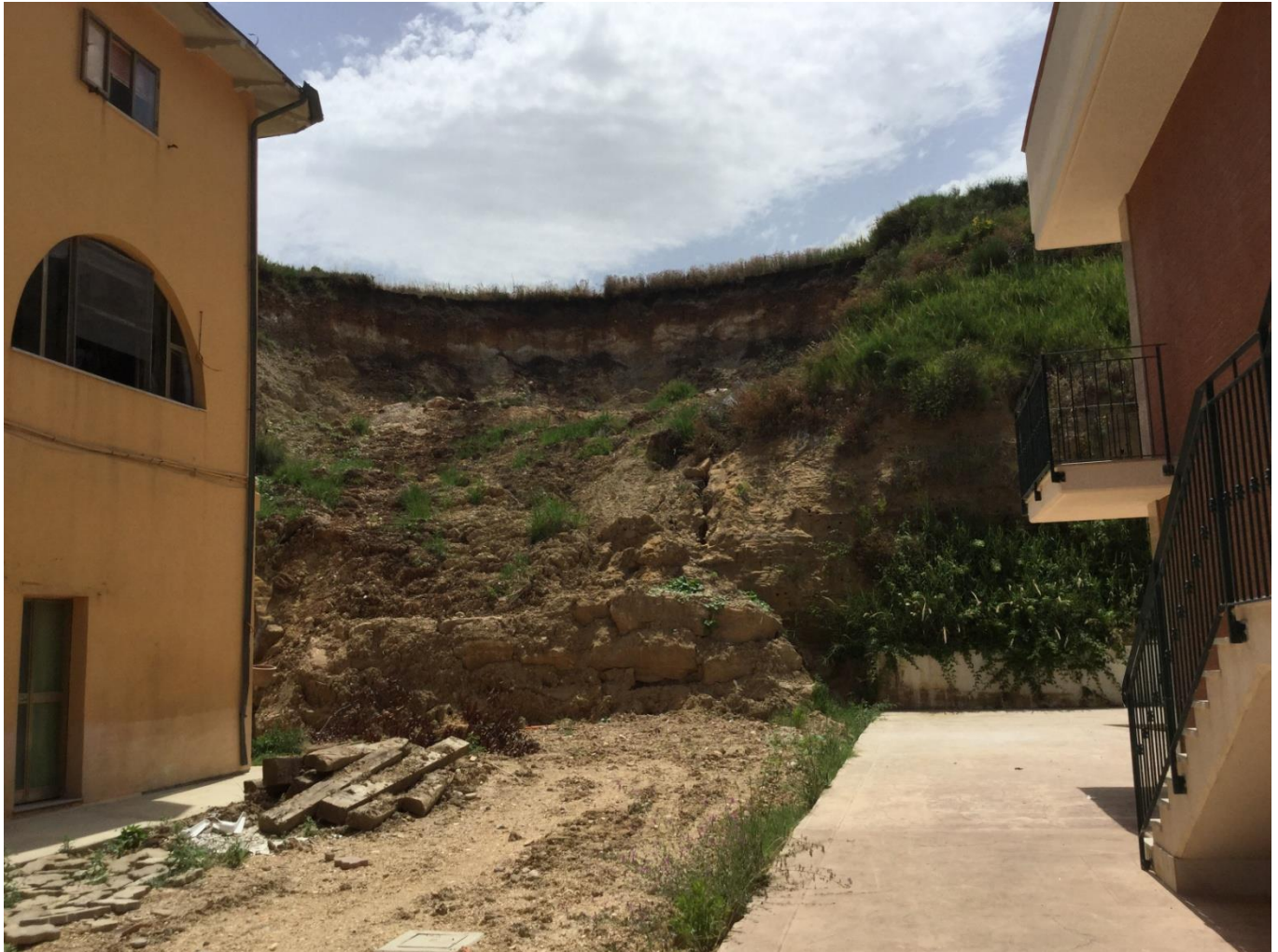
Foto 11 – Movimento franoso di genesi complessa presente nei settori nord-occidentali dell'area di studio, in località Rio Vivo, al margine della superficie terrazzata su cui sorge l'area industriale di Termoli.
