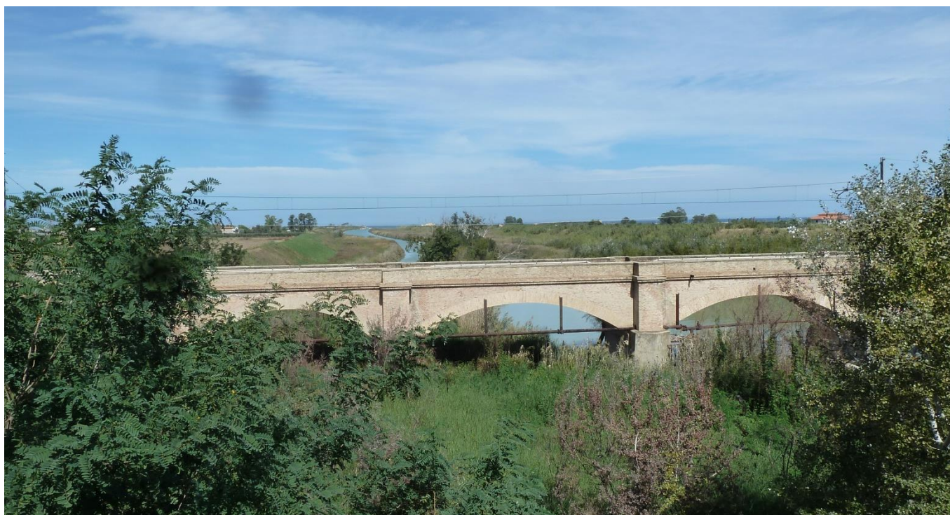
Foto 10 – Vista panoramica dell'alveo attuale del F. Biferno, in prossimità di Località Marinelle Vecchie.
