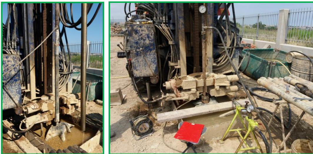
Foto 2.6 - Immagini di prova in corso in S 1Gall; a sinistra, otturatore semplice utilizzato.
