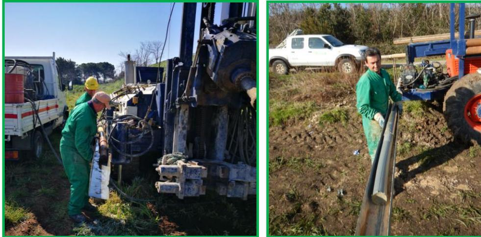
Foto 2.2 – Estrusione del carotaggio con estrusore a pistone
