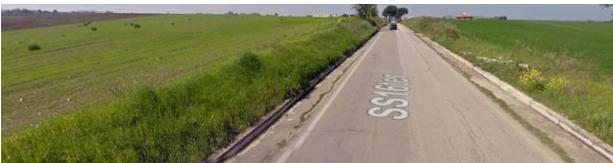
Arginelli e banchine conformi al D.M. 05/11/2001.<br>Banchine delimitate con strisce di margine della carreggiata di larghezza conforme alle prescrizioni normative.<br>Barriere di sicurezza secondo D.M. 18/02/1992, D.M. 03/06/1998 e D.M. 21/6/2004.<br>Scarpate con inclinazione 2/3 rispetto all'orizzontale. | SI                              |
