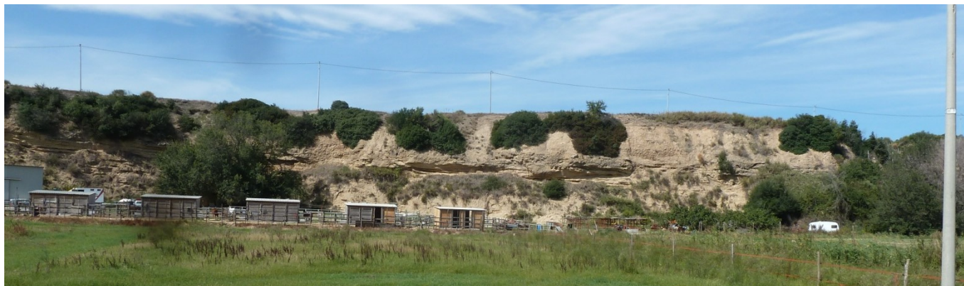
Figura 5 – Imbocco lato Termoli.
