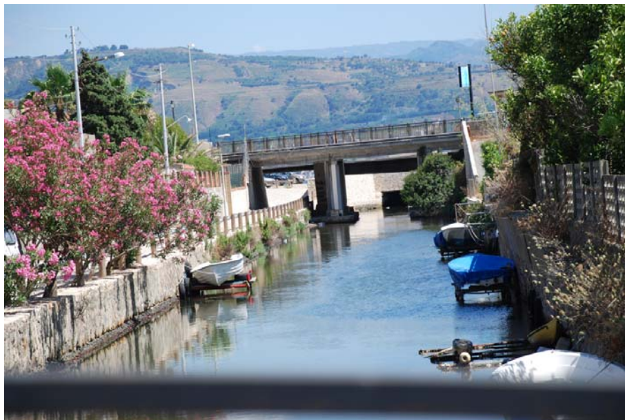
Figura 10. Località Ganzirri: visuale del ponte di via Circuito sul canale
