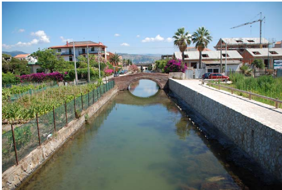
Figura 11. Località Ganzirri: visuale del ponte di via Canalone
