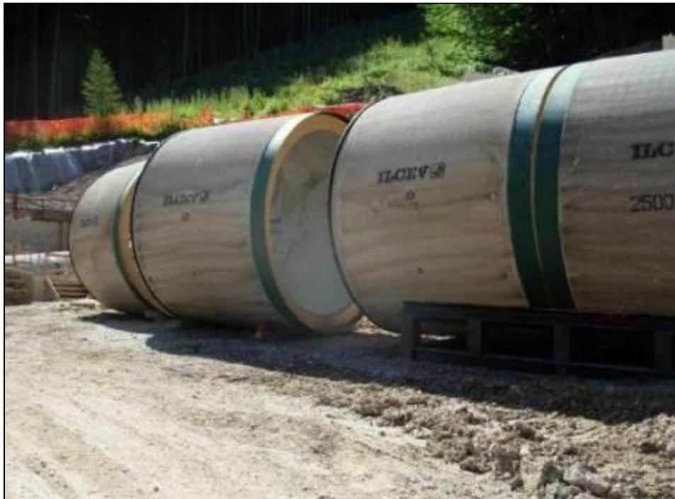
Fig. 2.13/E – Stoccaggio tubi in c.a.
