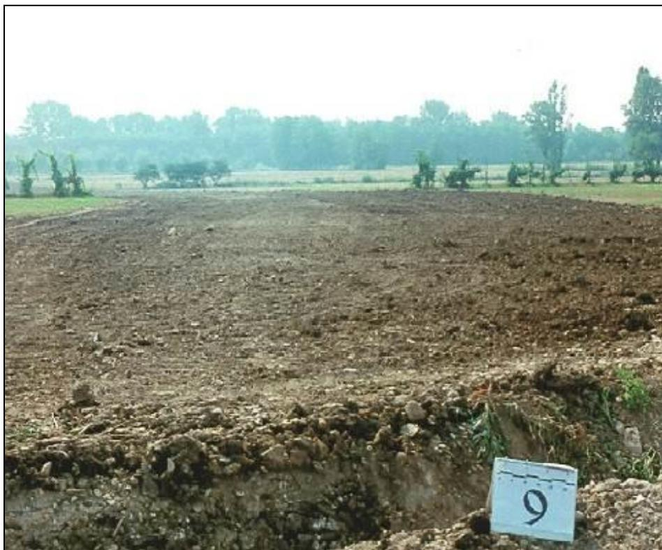
**Fig. 2.12/A - Rinterro della condotta**
