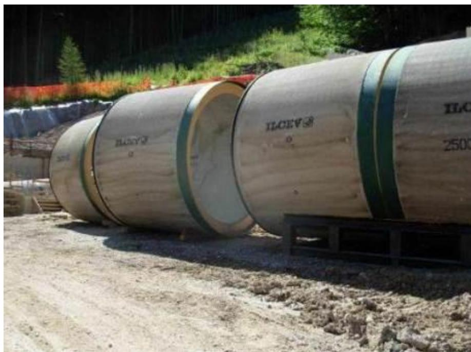
**Fig. 2.3.9/E** – Stoccaggio tubi in c.a.
