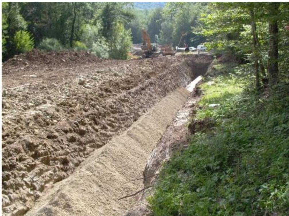
**Fig. 2.3.7/B - Rinterro della condotta**
