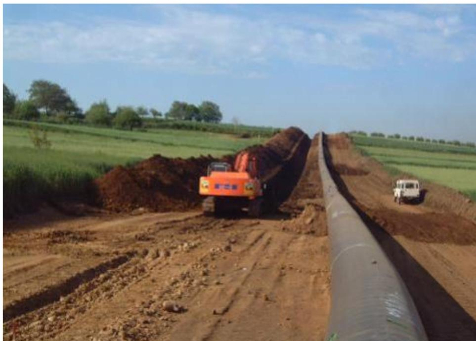
**Fig. 2.3.5/A** - Foto tipica di scavo della trincea
