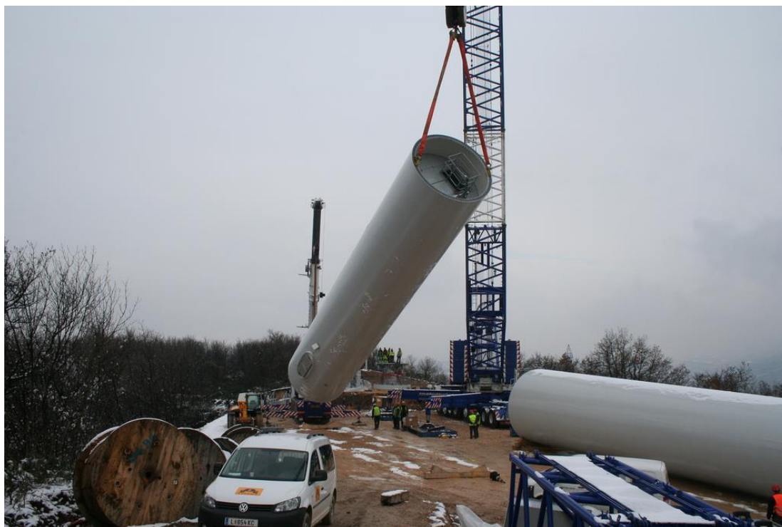
Figura 3. Smontaggio dei tronchi
