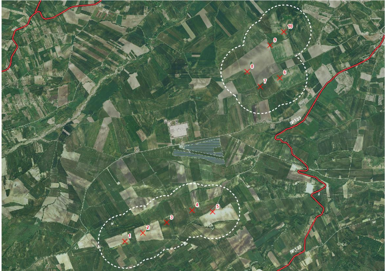
Figura 6: Viabilità interessata dalla rischio di gittata nell’area dell’impianto.
