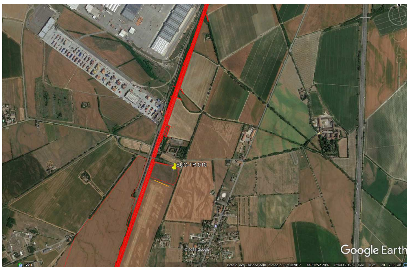
Figura 252 – Inquadratura Aerofotogrammetrica area di cantiere
