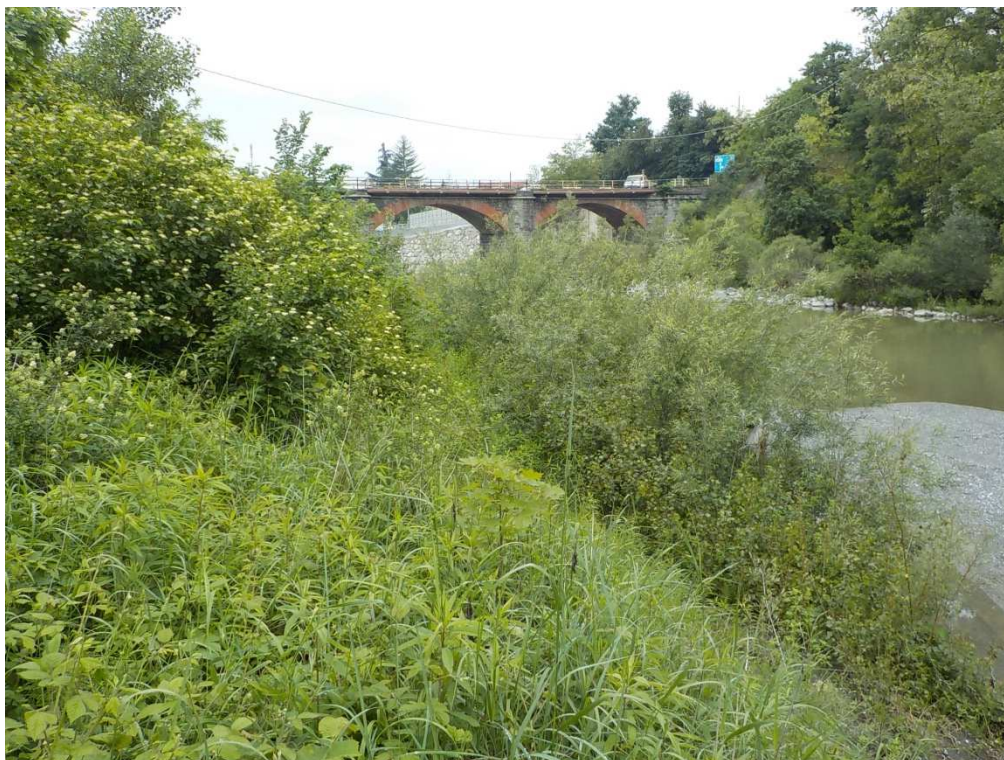
Figura 66: panoramica stazione di rilievo VEG-GA-010
