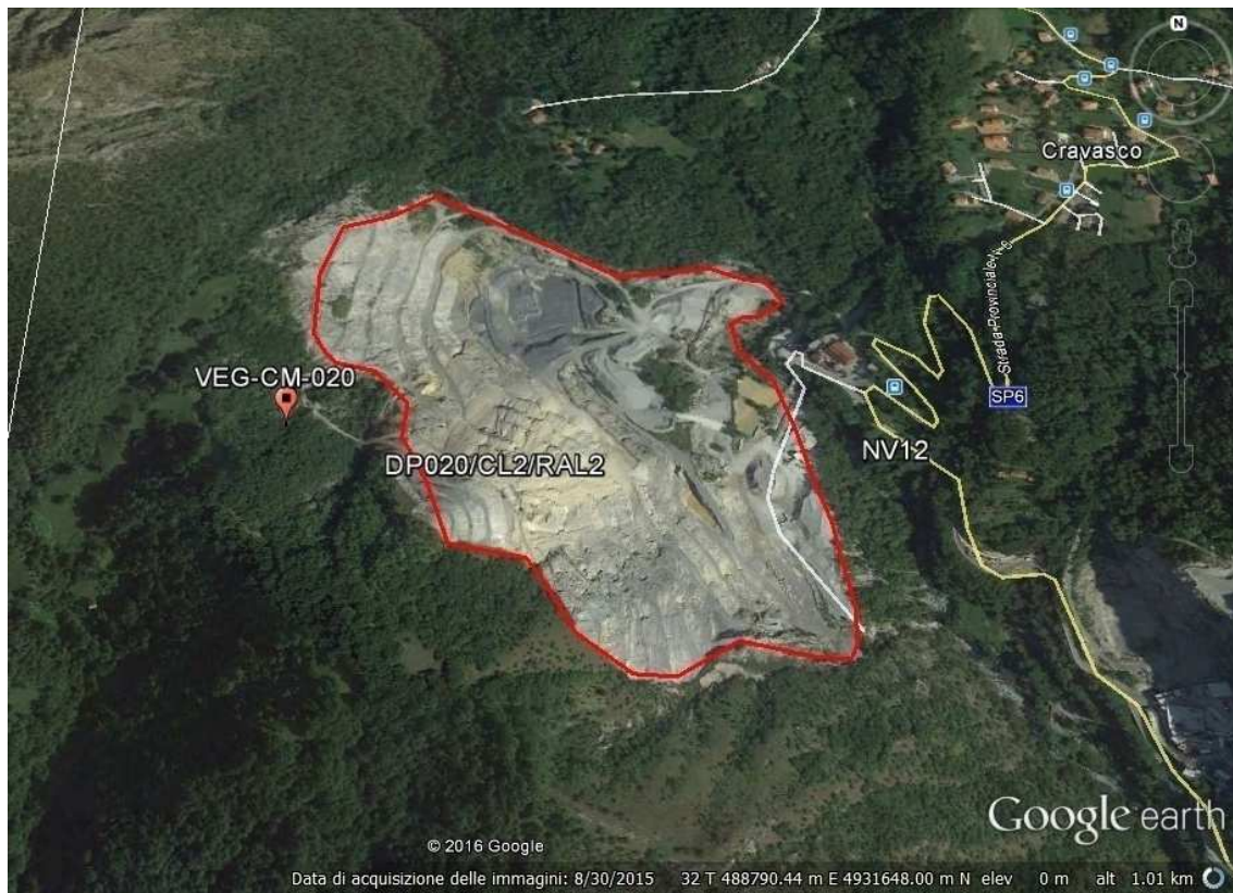
Figura 29: localizzazione stazione di rilievo VEG-CM-020
