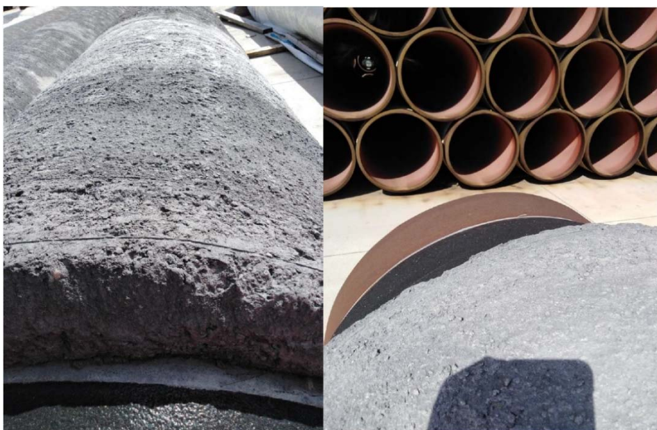
Fig. 6: Superficie di gunita che riveste i tubi - rif. fig. 6.1 dello Studio Preliminare Ambientale
