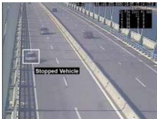
Figura 5.8.8: Esempio che mostra un sistema AID che rileva un veicolo fermo sul ponte.
