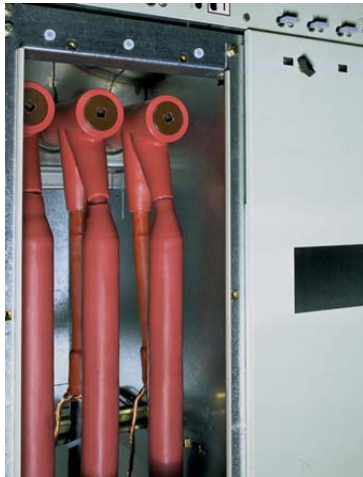
Fig. 5.12.9 Apparecchiatura di comando con limitatore Raychem o simile
