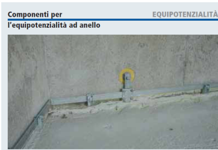
Fig. 6.6.3 - 2 Equipotential bonding bar
