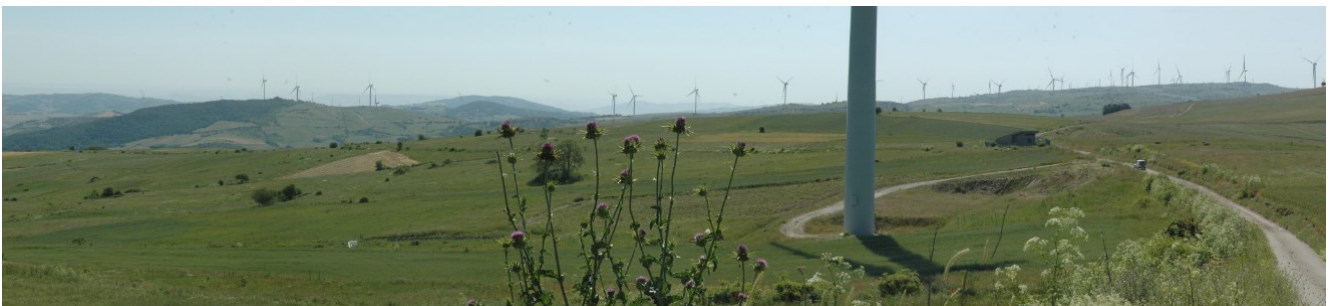
Figura 17 Vista panoramica area Nord dall'accesso al Parco
