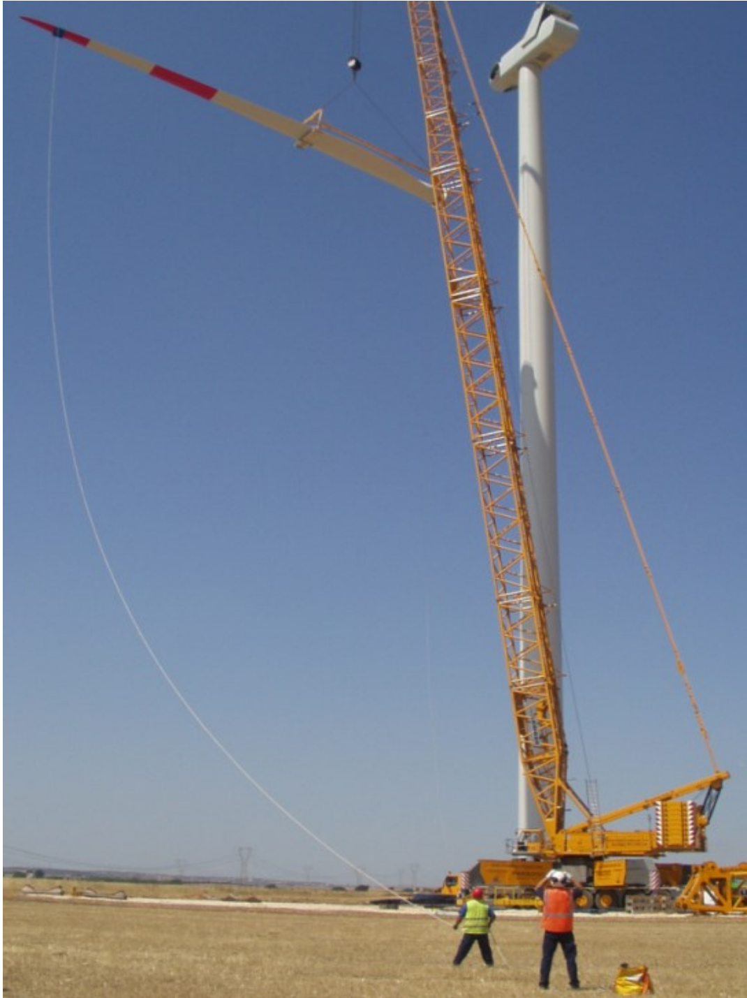
Figura 39 Montaggio pala
