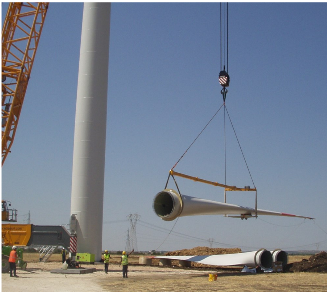
Figura 38 Montaggio pala
