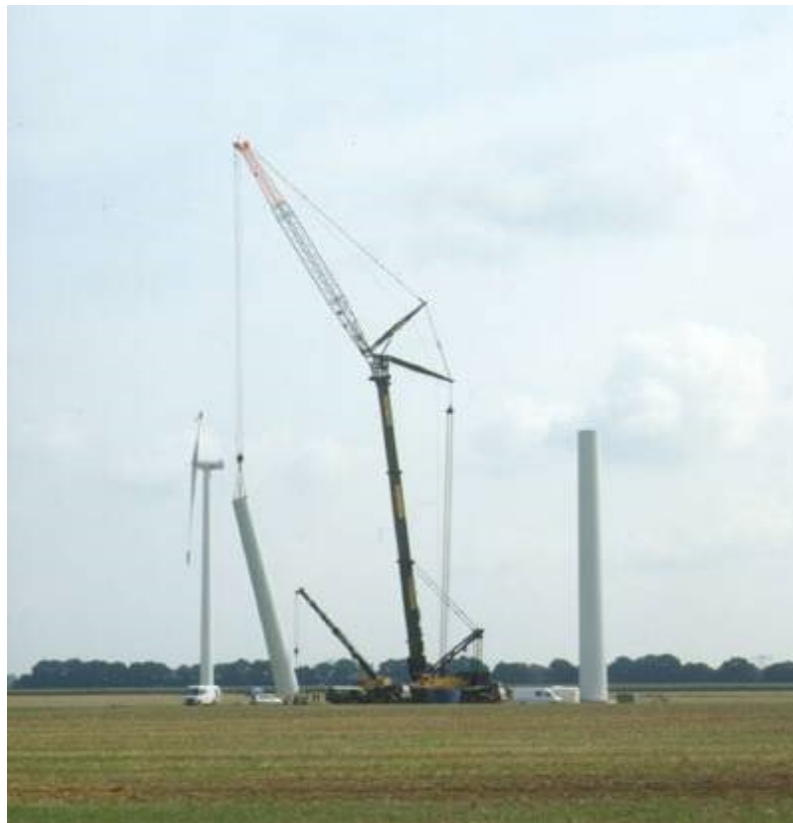
Figura 32 Montaggio secondo troncone torre
