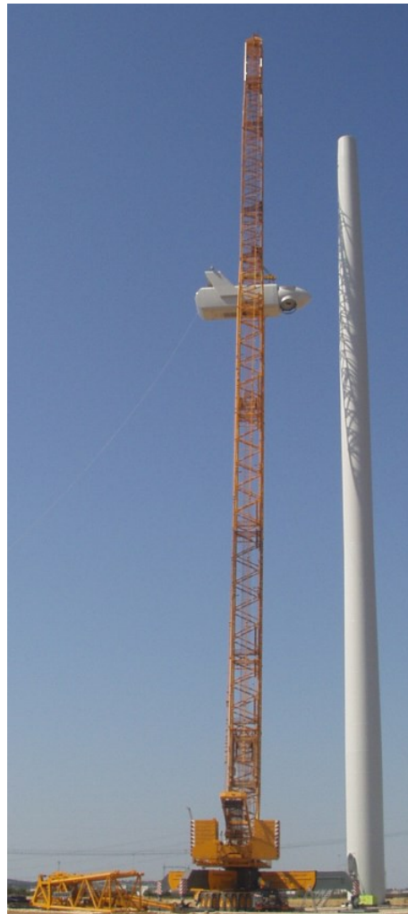
Figura 36 Montaggio Navicella
