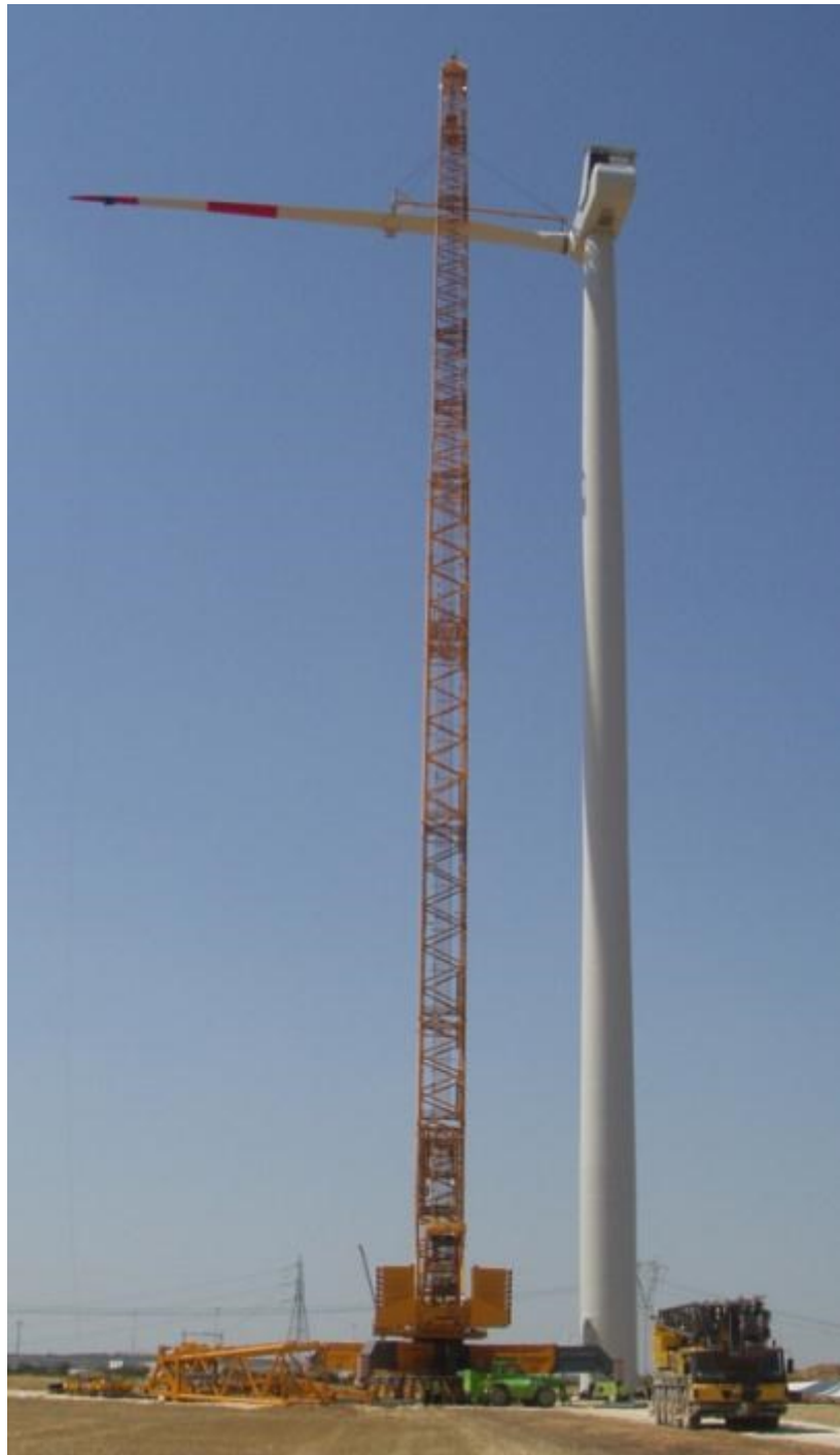
Figura 40 Montaggio pala
