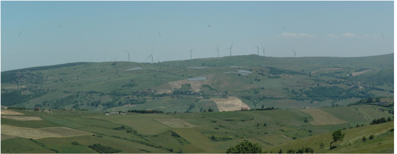
Figura 19 Vista panoramica dell'area SUD del Parco
