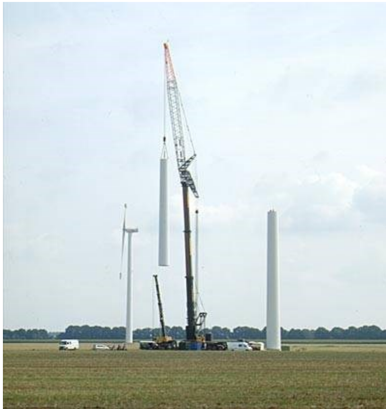
Figura 33 Montaggio secondo troncone torre
