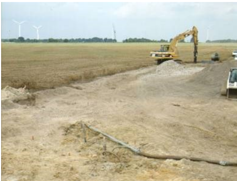
Figura 30 Preparazione pista/piazzola
