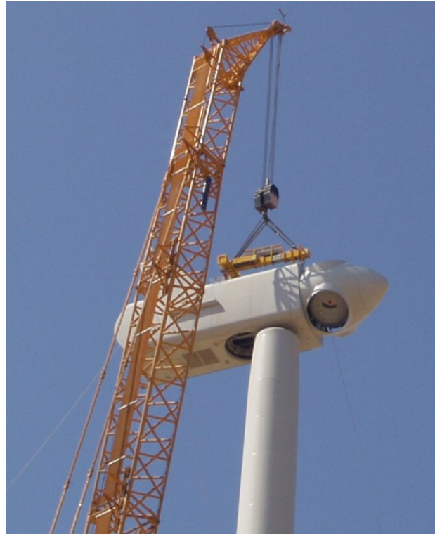
Figura 37 Montaggio Navicella
