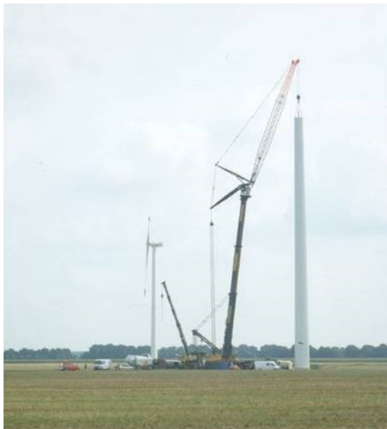
Figura 34 Montaggio secondo troncone torre
