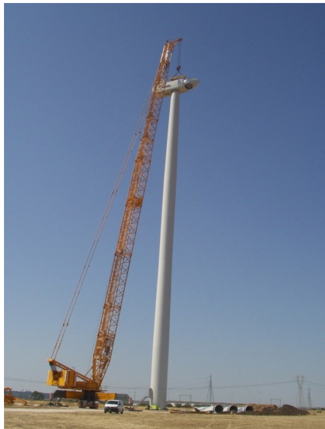
Figura 11 Fasi di montaggio navicella Vestas
