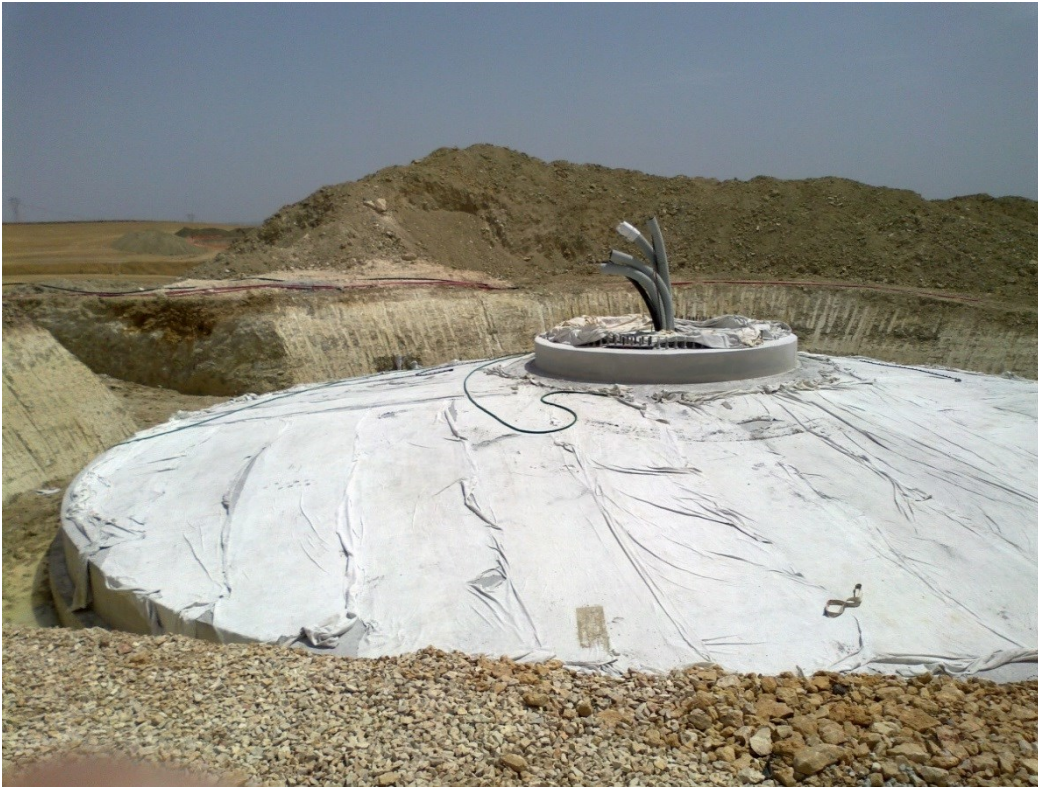
Figura 5 Plinto gettato e ricoperto con telo bagnato per ridurre il ritiro in caso di alte temperature
