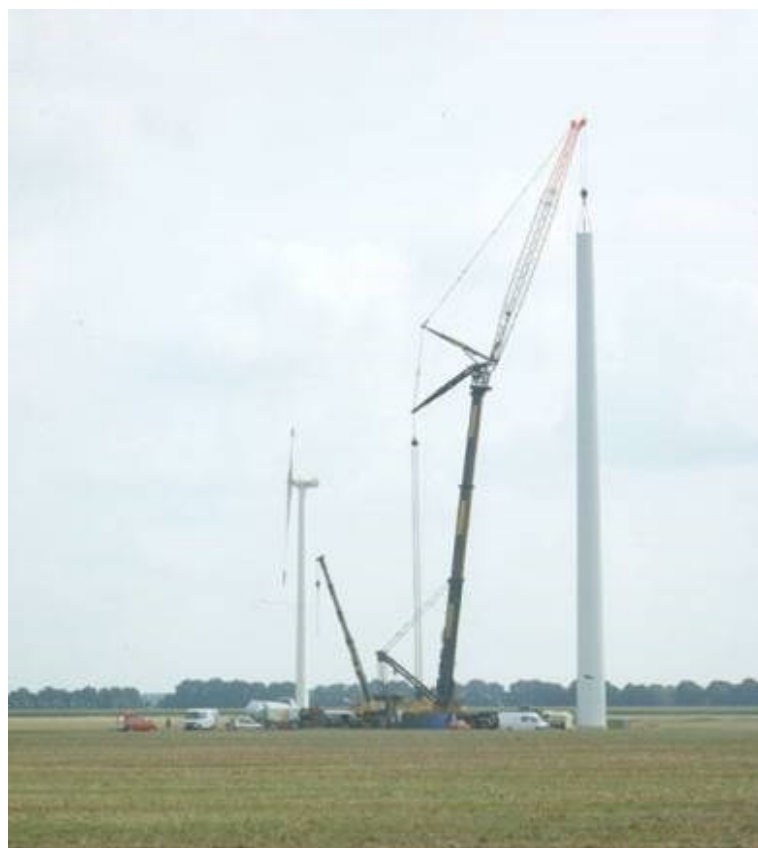
Figura 8 Montaggio secondo troncone torre
