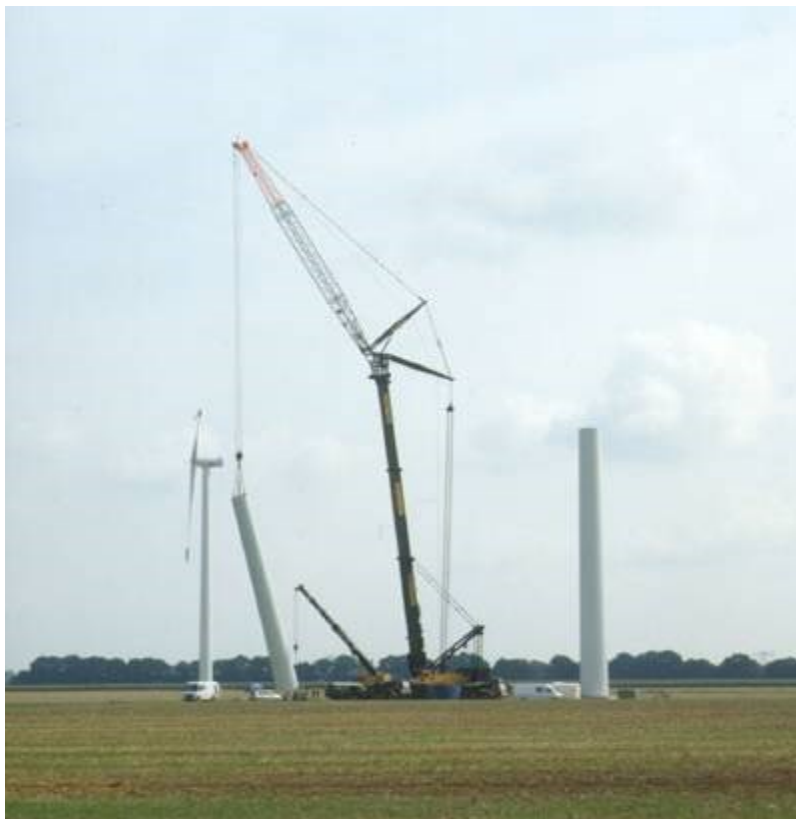
Figura 6 Montaggio secondo troncone torre
