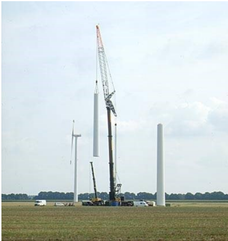
Figura 7 Montaggio secondo troncone torre
