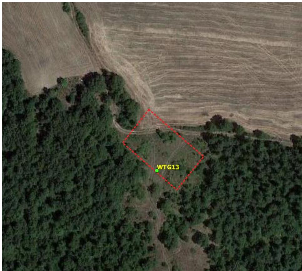
Fig. 20 - Bosco a prevalenza di roverella interessato dall'installazione del wtg13 e della relativa piazzola
