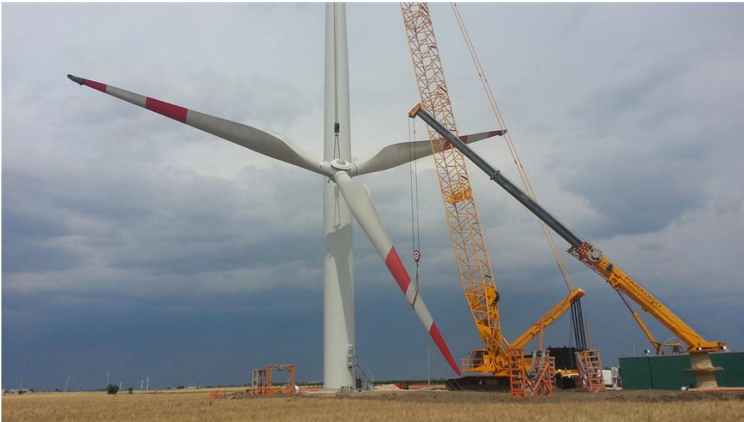
Figura 2. Smontaggio delle pale
