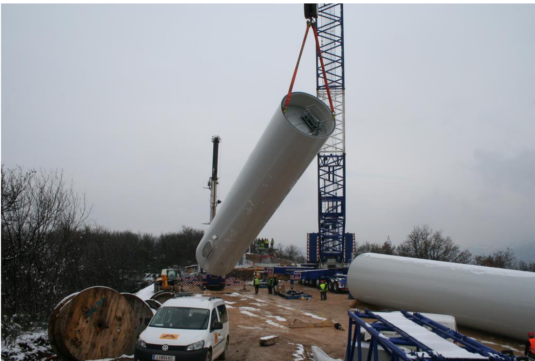
Figura 3. Smontaggio dei tronchi
