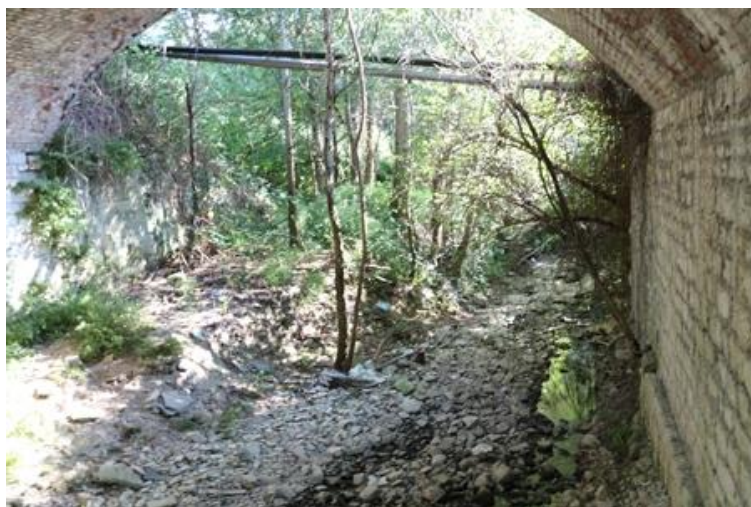
FIGURA 6-22: ALVEO DEL TORRENTE ASSINO SOTTO AL PONTE DELLA S.S. 219
