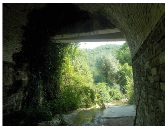
FIGURA 6-17: FOSSO BRILLI IN CORRISPONDENZA DEL PONTE SULLA S.S. 219
