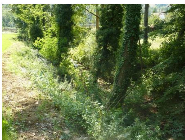
FIGURA 6-1: T. S. GIORGIO A MONTE DEL PONTE SULLA S.S. 219
