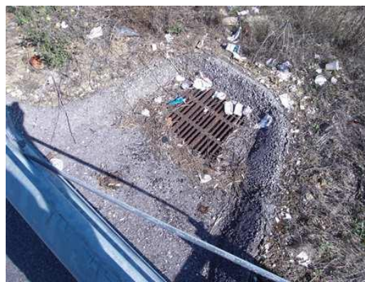
FIGURA 4 – PIANTA POZZETTO DI RACCOLTA ACQUE DI PIATTAFORMA IN RILEVATO CON RILEVO FOTOGRAFICO DI TALE SOLUZIONE NEL TRATTO DELLA VARIANTE GIÀ APERTA AL TRAFFICO DA GUBBIO A LOC. MOCAIANE
