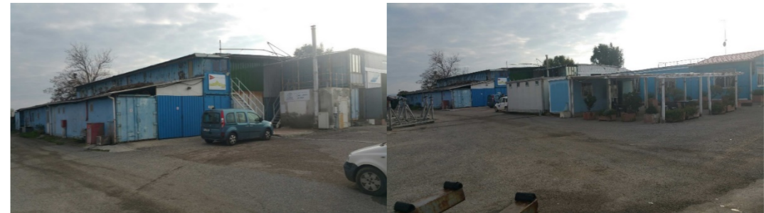
Immagini rappresentative dello stato attuale in area cantiere navale.
