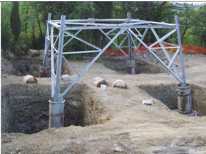
Figura 14 - Realizzazione di fondazioni superficiali tipo CR per un sostegno a traliccio. Nell'immagine si possono osservare le quattro buche, la base del sostegno collegata alla fondazione tramite i "monconi" ed i casseri utilizzati per i quattro "colonnini"
