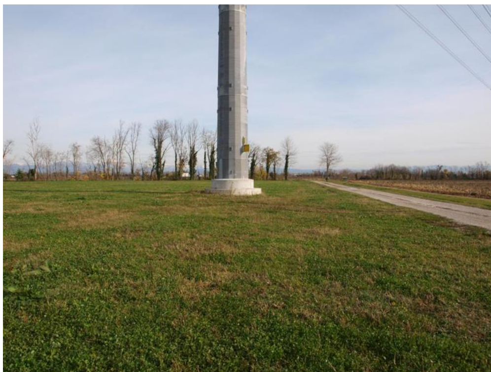
Figura 63 - Intervento di ripristino a prato sulla linea 380 kV Udine Ovest-Udine Sud
