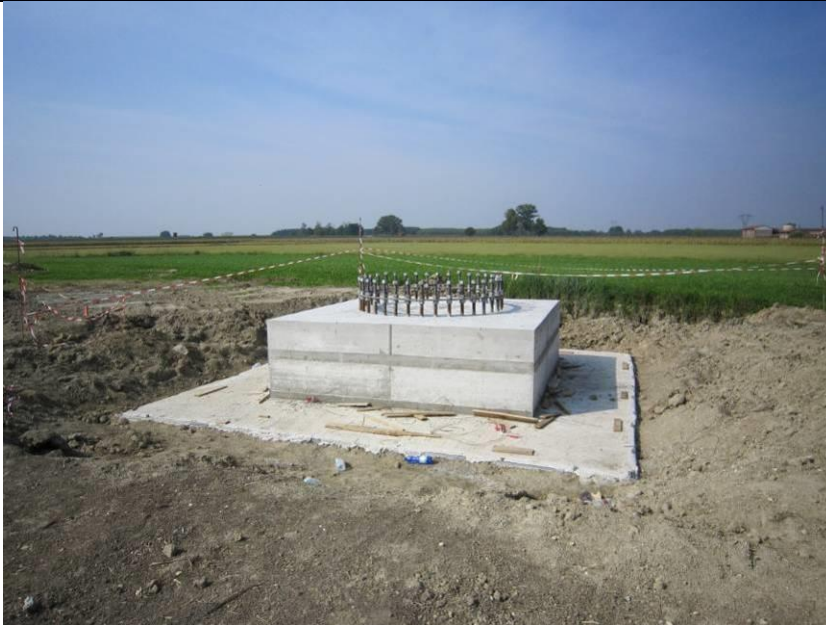
Figura 17 - Realizzazione di fondazioni superficiali tipo plinto a monoblocco per un sostegno monostelo.
