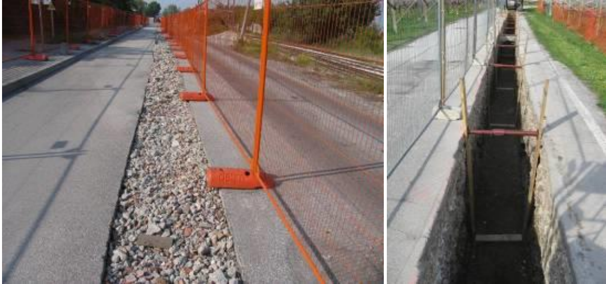
Figura 40 - Taglio dell'asfaltatura e scavo aperto
