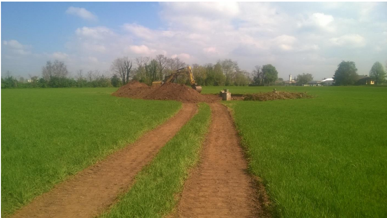
Figura 59 - Esempio di pista temporanea su terreno agricolo
