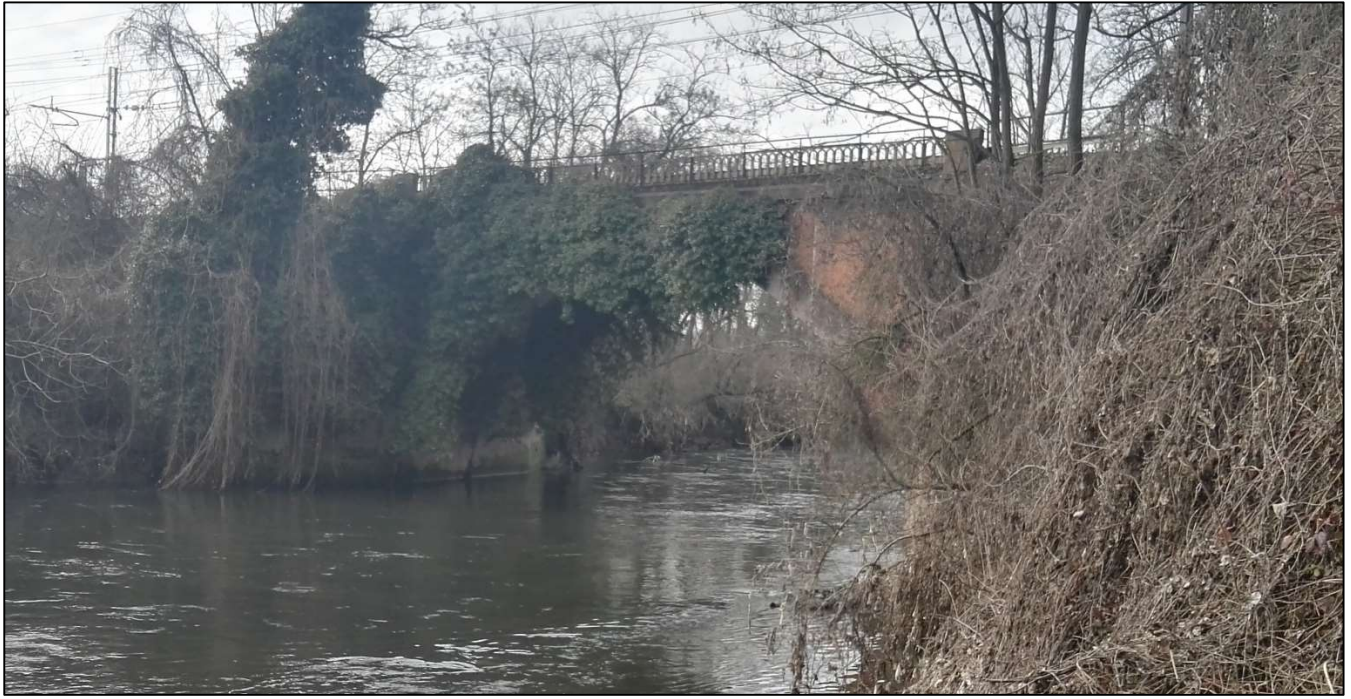
Figura 1 - Ponte ferroviario esistente sul fiume Lambro Meridionale, comune di Pieve Emanuele
