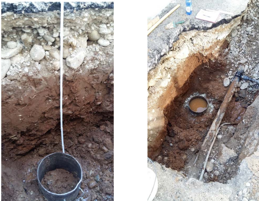
Figura 13 - Fasi di esecuzione delle prove di permeabilità.
