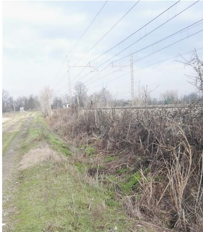
Figura 18 - Problemi di crescita della vegetazione nei fossi in terra.
