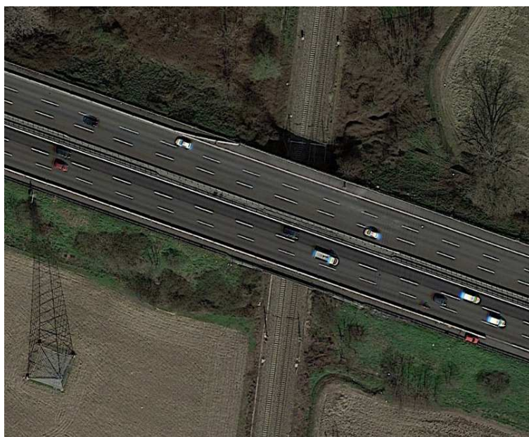
Figura 1-1: Vista d'insieme dell'opera esistente (Google Earth)
