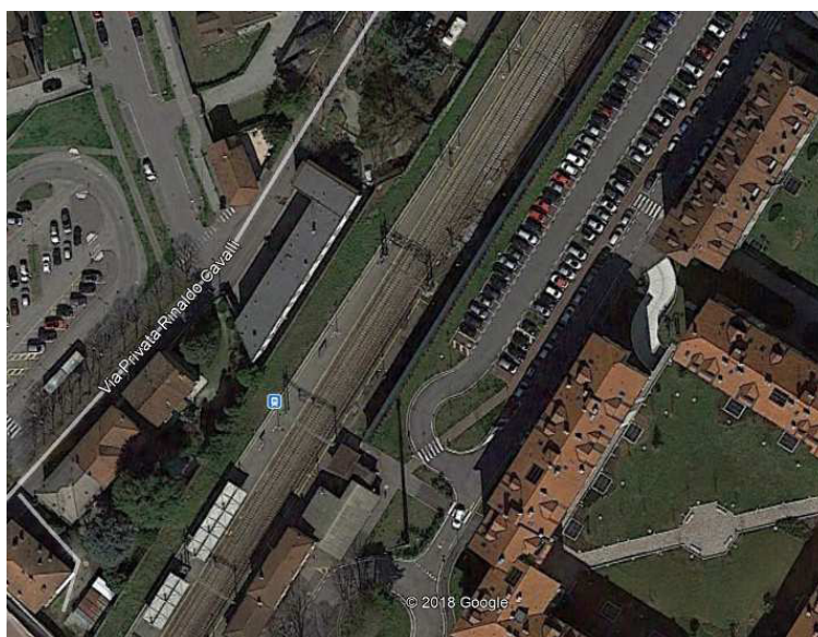
Figura 1-1: Vista d'insieme dell'opera esistente (Google Earth)
