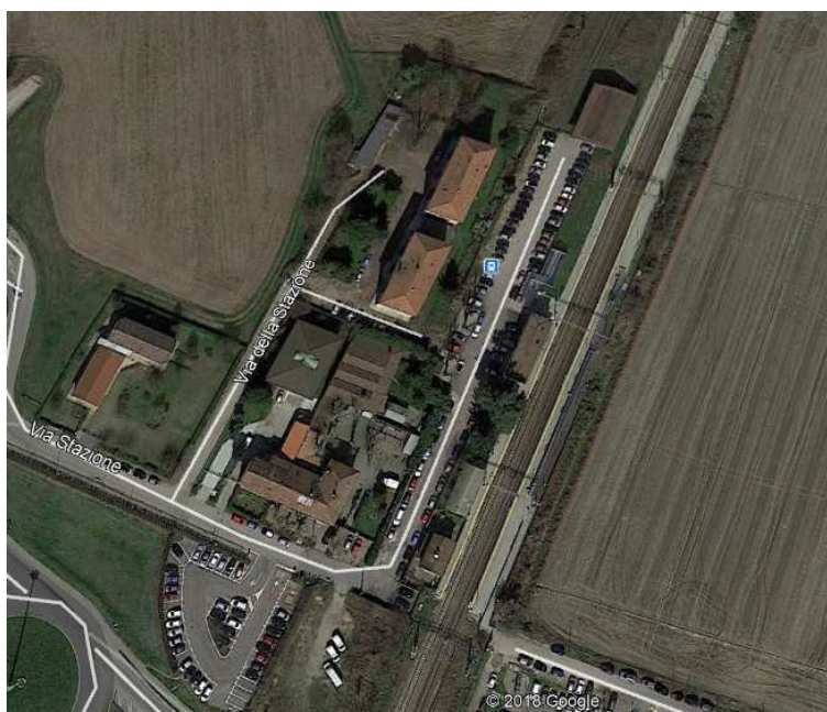
Figura 1-1: Vista d'insieme dell'opera esistente (Google Earth)
