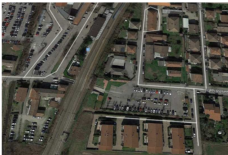
Figura 1-1: Vista d'insieme dell'opera esistente (Google Earth)
