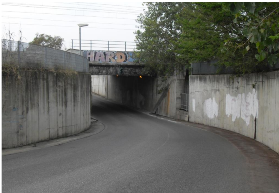
(vista sottovia sulla SP148 – franco 4,00m)
