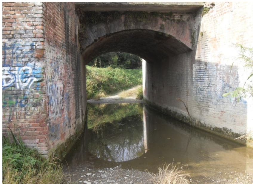
Vista lato est del sottopasso esistente (lato oggetto del prolungamento)
