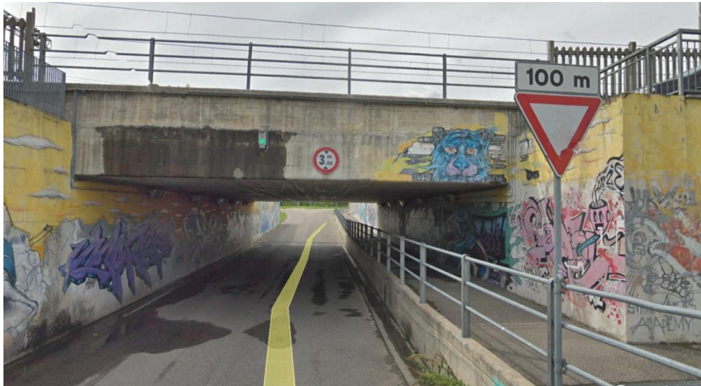
Vista sottopasso a franco ridotto oggetto di prolungamento (lato est)
