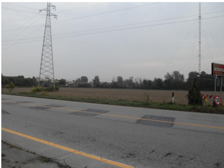
Foto 1 (vista dell'area e viabilità d'accesso da via Casina Nuova)
