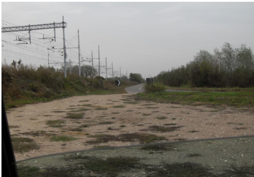
Vista dell'area della viabilità di accesso
