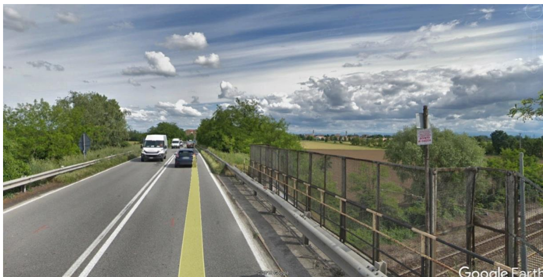
Vista SP 40 di scavalco della linea ferroviaria per il collegamento delle due aree 1_AT.05
