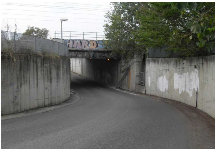
Foto2 (vista sottovia sulla SP148 – franco 4,00m)
