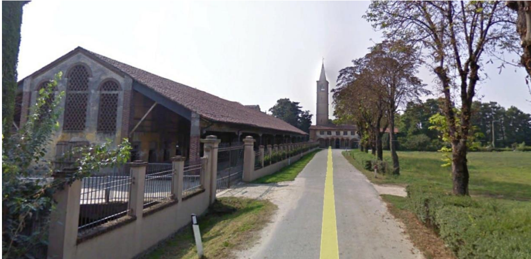
Vista della viabilità di accesso lato ovest della linea ferroviaria (SP164)
