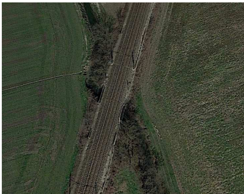
Figura 1-1: Vista d'insieme dell'opera esistente (Google Earth)
