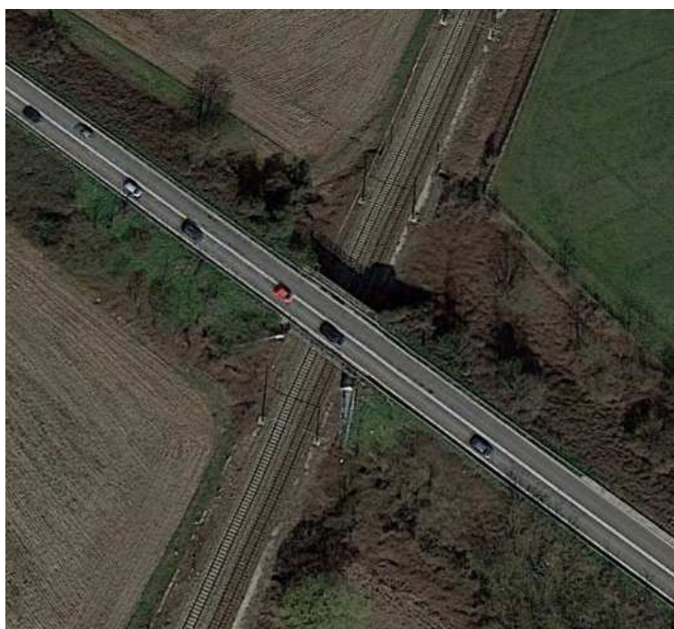
Figura 1-1: Vista d'insieme dell'opera esistente (Google Earth)
