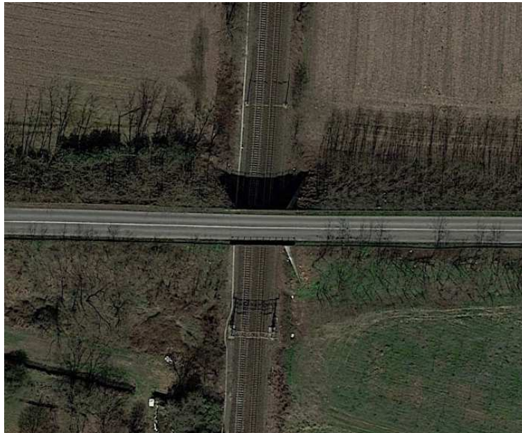
Figura 1-1: Vista d'insieme dell'opera esistente (Google Earth)
