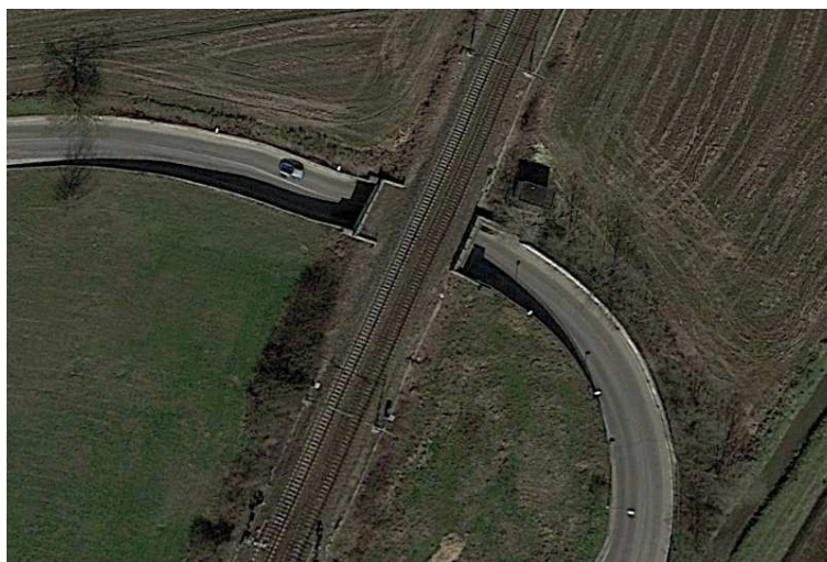
Figura 1-1: Vista d'insieme dell'opera esistente (Google Earth)
