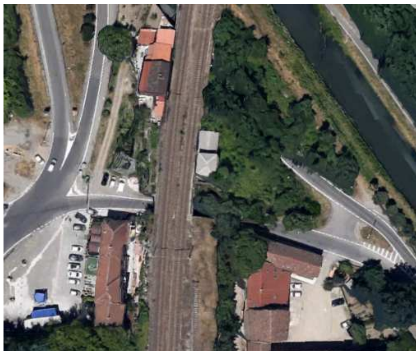
Figura 1-1: Vista d'insieme dell'opera esistente (Google Earth)
