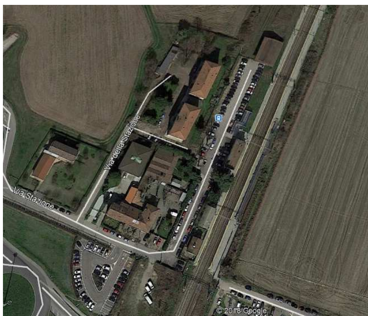
Figura 1-1: Vista d'insieme dell'opera esistente (Google Earth)
