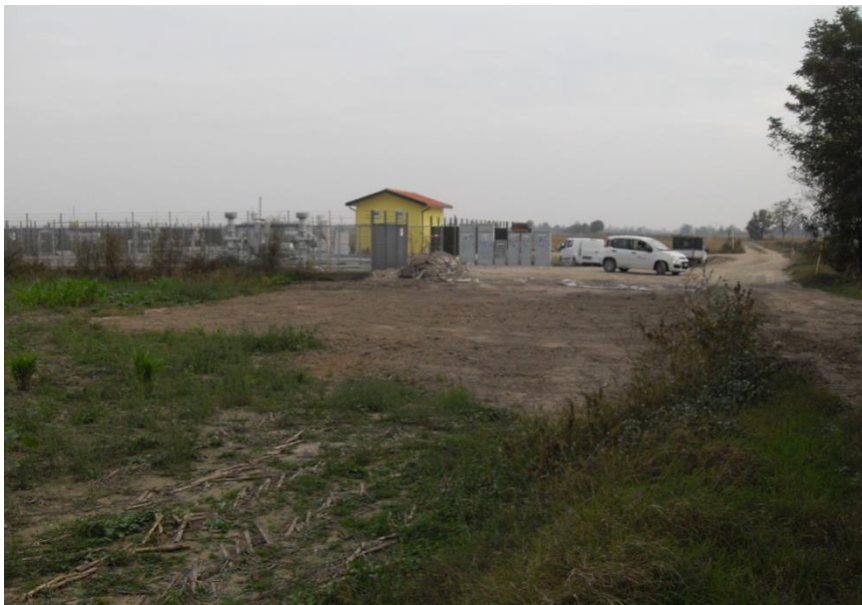
Vista della pista d'accesso al cantiere 2_AT.11
