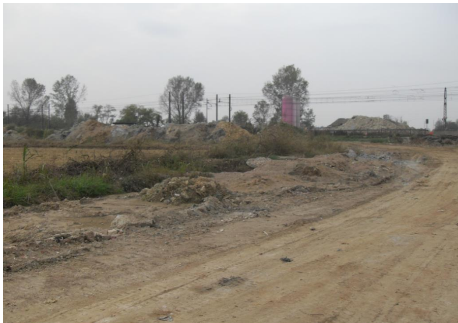
Foto 1 (vista dell'area allo stato interessata dai lavori - SP27)
