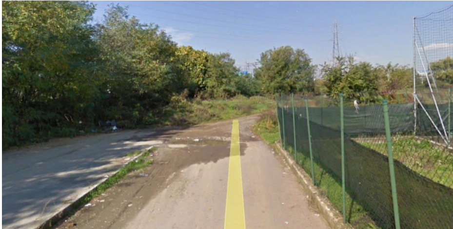
Vista della viabilità d'accesso 2_AT.16-1 (Via Alzaia)
