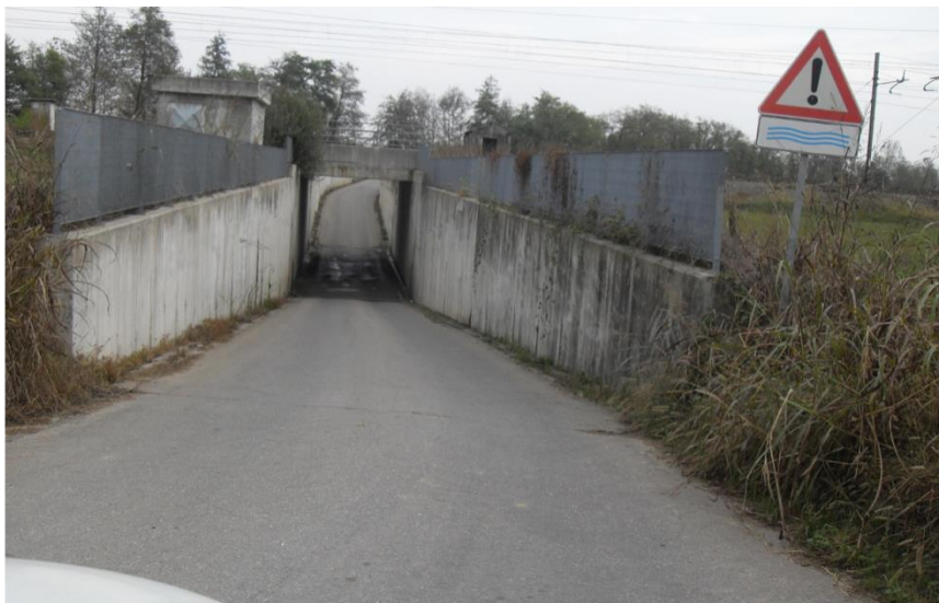
Vista della viabilità di accesso- sottovia esistente
