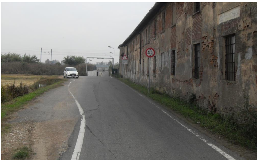
Vista della viabilità di accesso al cantiere (strada Cantone Tre Miglia)
