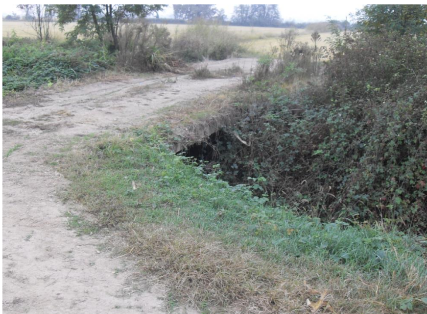
Vista della pista d'accesso al cantiere 2_AT.10 (scavalco di un canale esistente)
