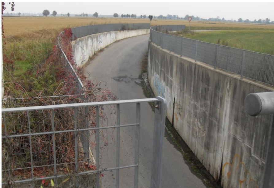
Vista del sottopasso esistente interessato dall'opera VI09
