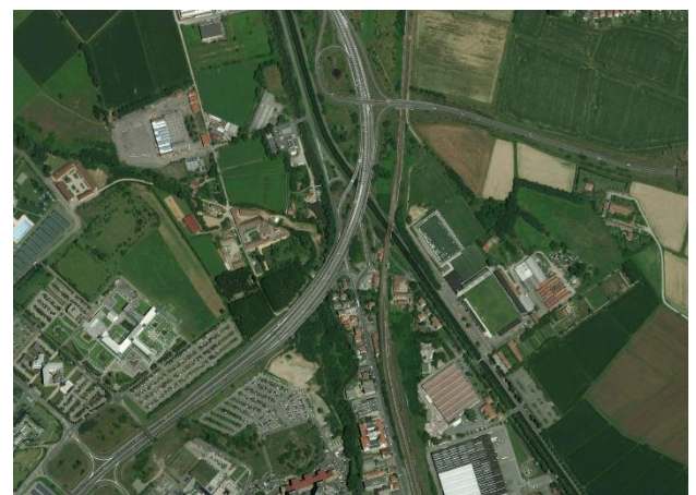
Pavia, area di cantiere AT.17
