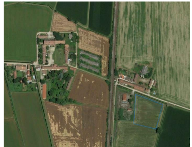
Città storica rurale, area di cantiere AS.17
