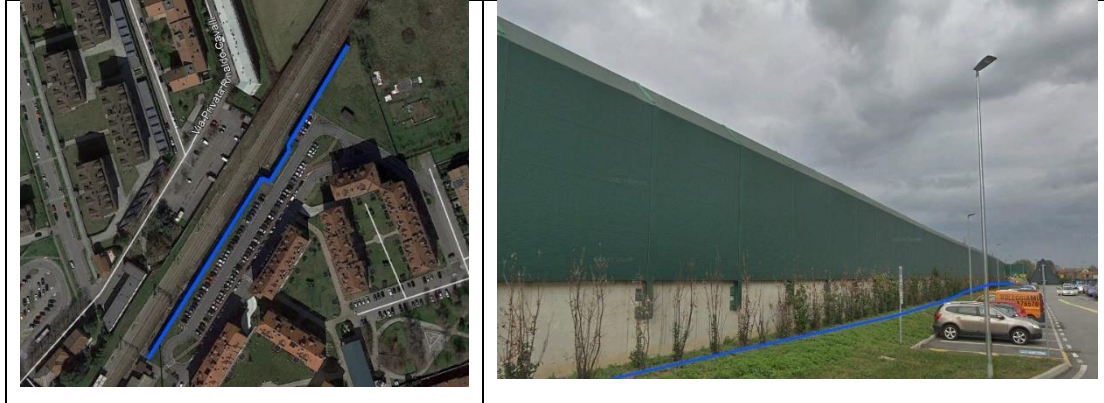
Figura 6-41 Barriera antirumore presso la stazione di Locate di Triulzi
