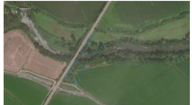
Fasce fluviali, aree di cantiere AT.04 -1 e AT.04-2
