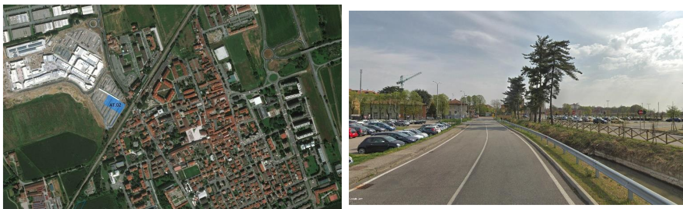
Figura 6-30 Area di cantiere AT.02 vista da via Milano, Locate Triulzi
