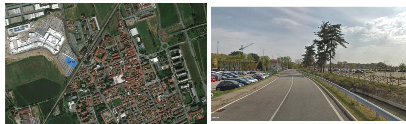
Figura 4-6 Area di cantiere AT.02 vista da via Milano, Locate Triulzi
