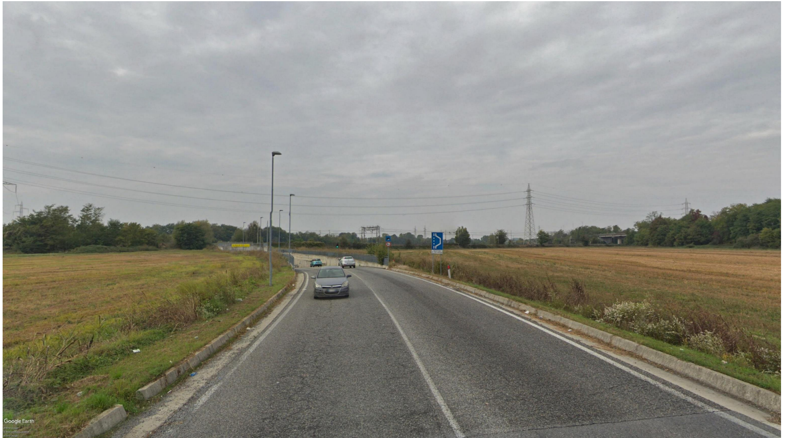
Figura 6-2 Visuali dirette delle opere in progetto. Ammodernamento dei sottoattraversamenti esistenti. A destra Locate Triulzi SP 164. I caratteri percettivi del paesaggio sono caratterizzati da ampie visuali sul paesaggio agrario grazie anche alla direzione prevalente della viabilità trasversale alla linea ferroviaria.
