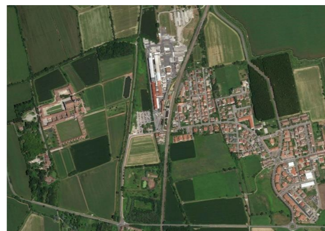
Certosa di Pavia area di cantiere CO.02
