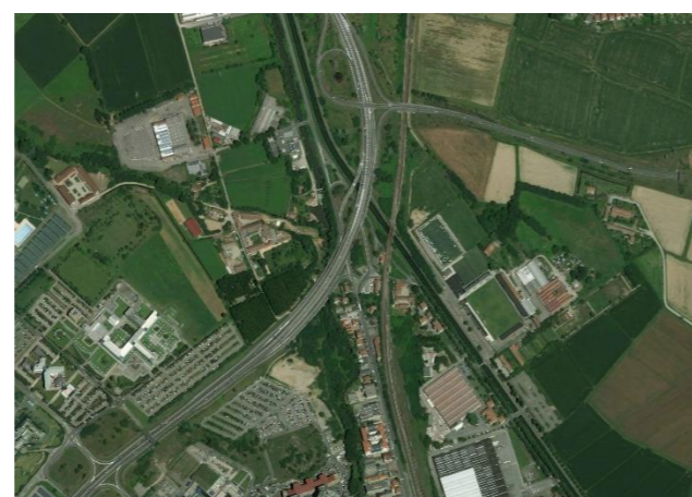
Pavia, area di cantiere AT.17
