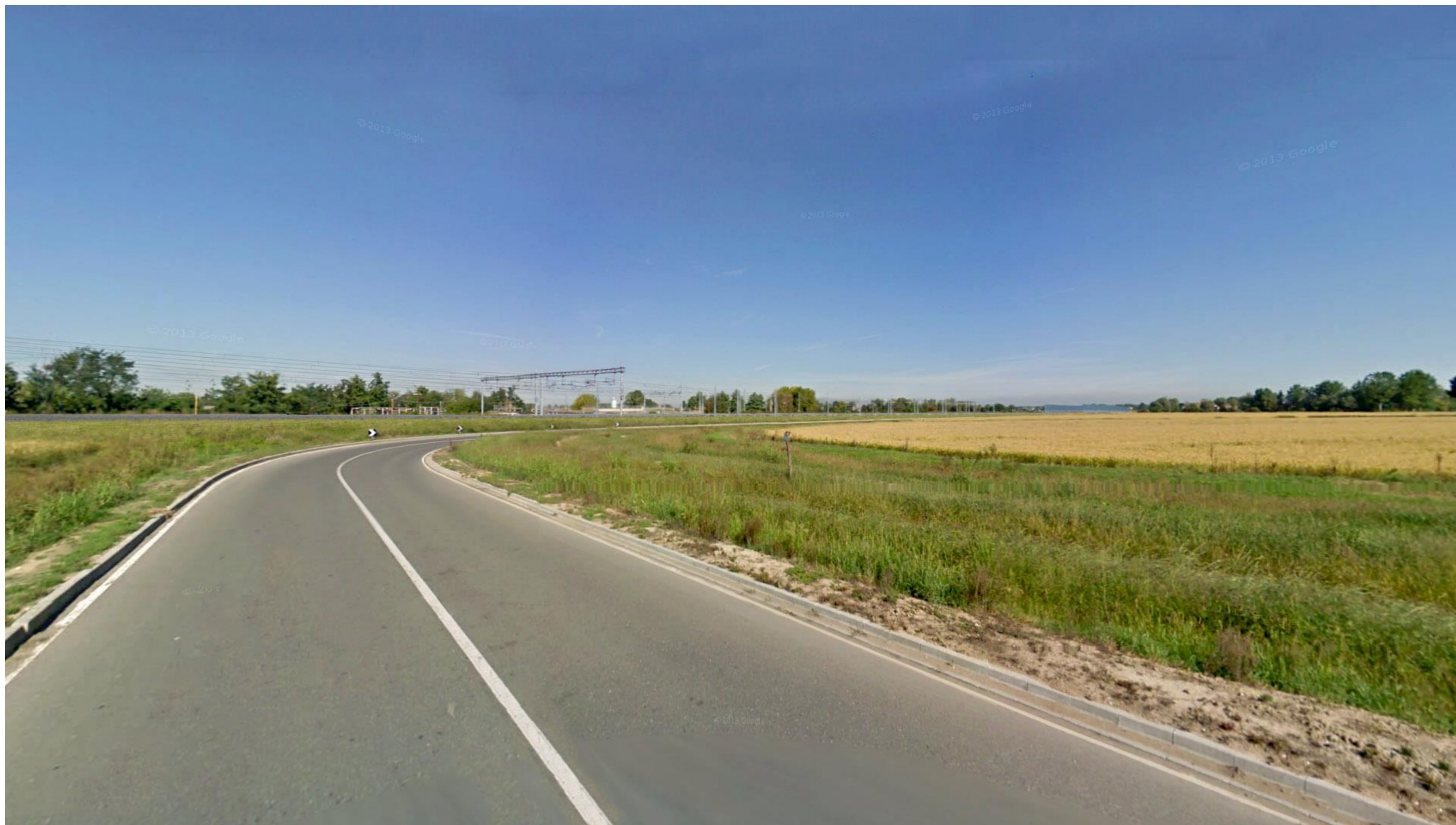
Via Machiavelli, Giussago. Condizioni percettive post operam
