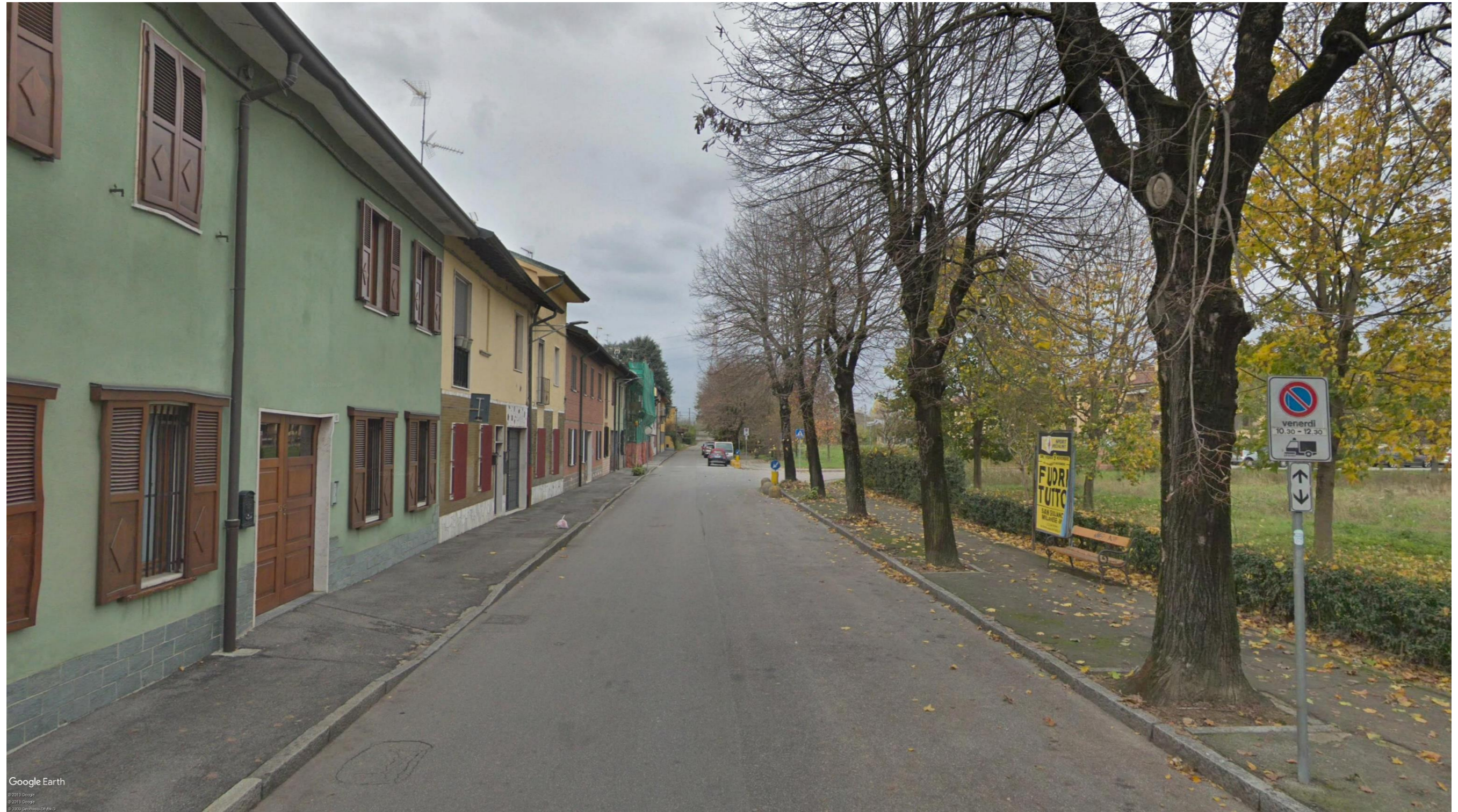
Figura 6-3 Visuale debolmente frammentata dalla presenza di viali alberati in viale Carso che costeggia l'abitato di Locate Triulzi.
