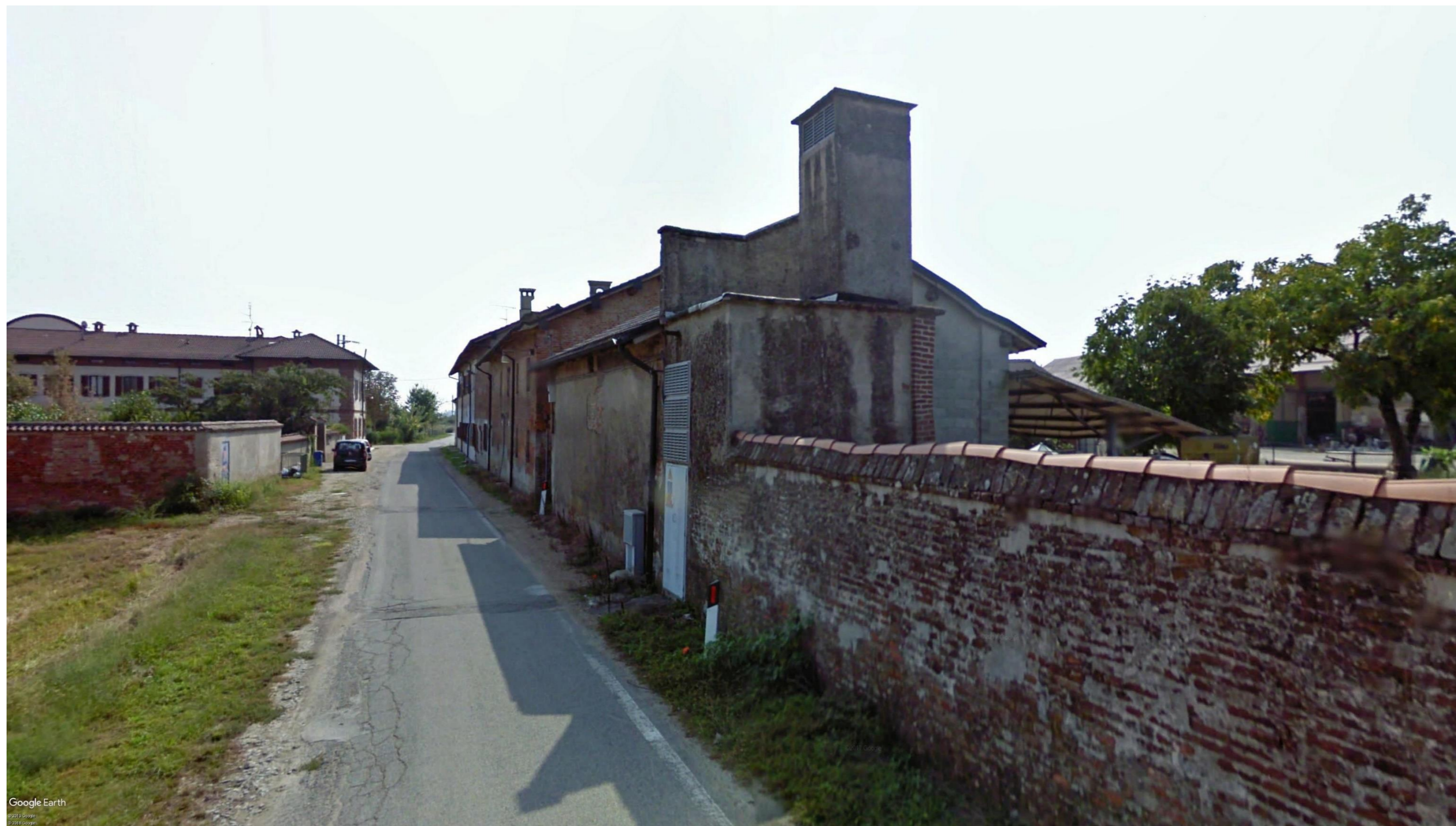
Figura 6-9 Cascina Birolo, Lacchiarella. Visuale in direzione della linea ferroviaria.
