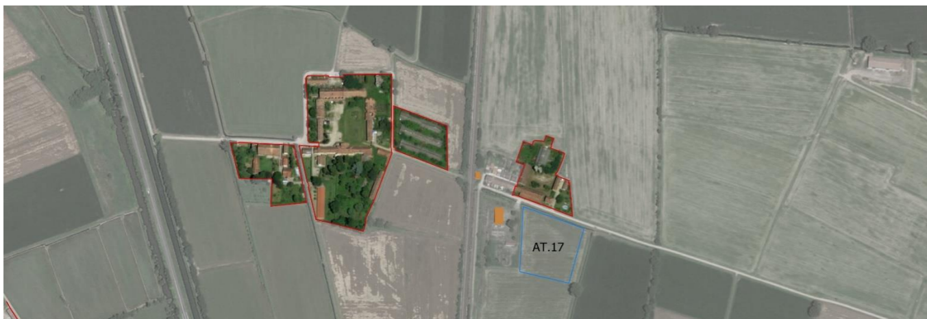
Figura 4-3 Cascine attive nel comune di Borgarello, Pavia. In rosso l'agglomerato storico, in giallo i fabbricati in demolizione
