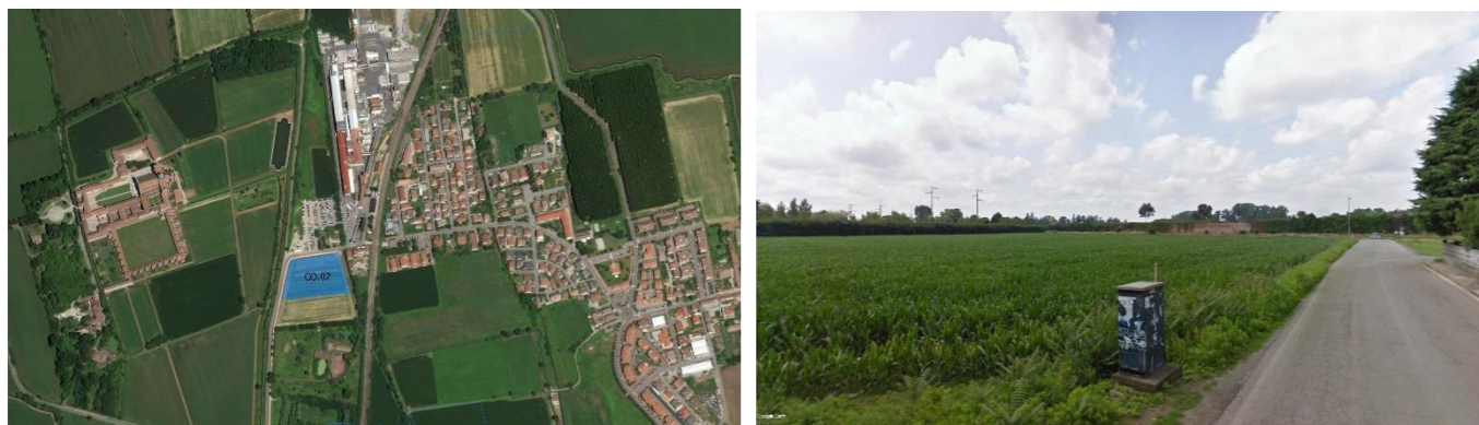
Figura 4-7 Area di cantiere CO.02. Sullo sfondo le mura della Certosa di Pavia presa da via Fratelli Cervi
